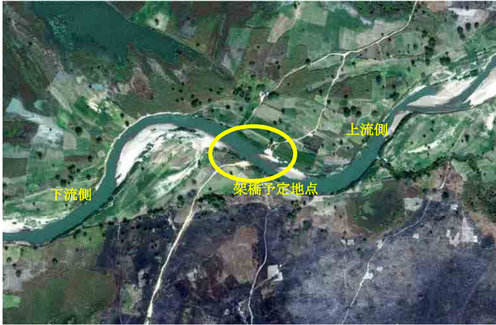
RN17 クモング橋架橋予定地点
