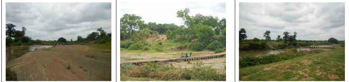
カラ川の河川現況及び沈下橋
