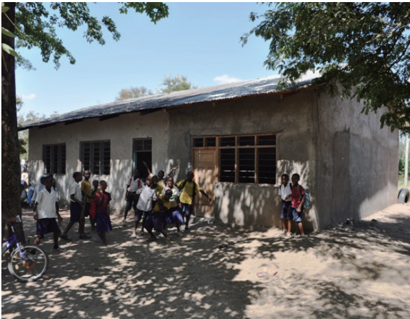
Mbeza Practicing School 幼稚舎資料室建設中（公立）
