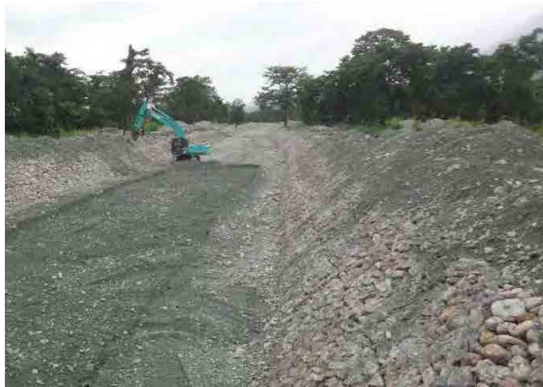
出所：調査団撮影（2014 年 7 月時点） <図 9-25> Shetikharey 川（右支川 1）の護岸工事
