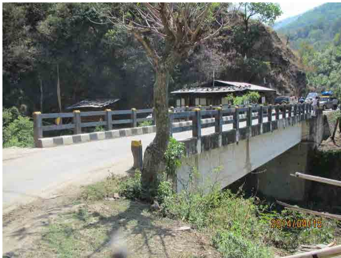
写真-14 橋梁調査 2014年4月15日～20日 A-11.Chuzomsa zam 橋
