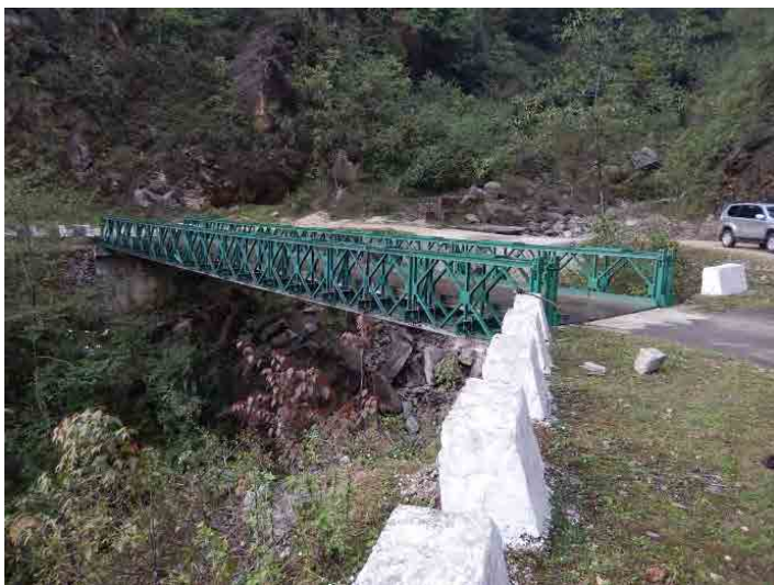
写真-6 橋梁調査 2014年4月15日～20日 A-3.Namling zam 橋
