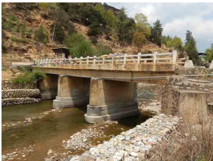
写真-25 橋梁調査 2014年4月19日 E-1.Dopshari zam 橋
