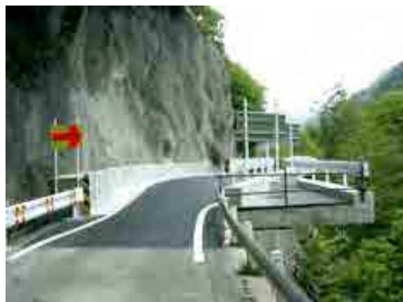
出所：NETIS 新技術情報提供システム ＜図 8-11＞工法の事例
