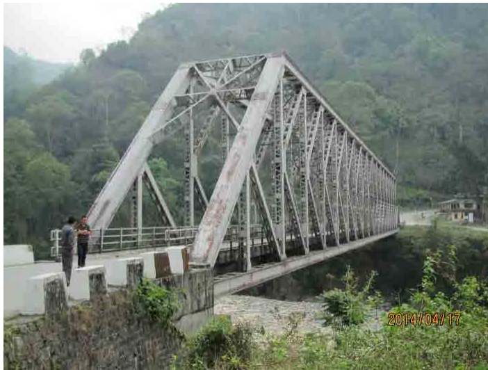
写真-19 橋梁調査 2014年4月15日～20日 B-5.Geleg(Aie) zam 橋
