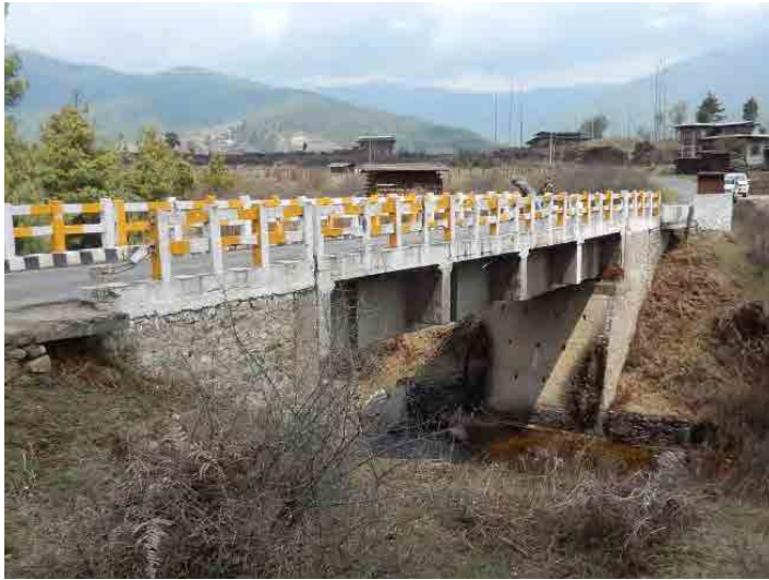
写真-10 橋梁調査 2014年4月15日～20日 A-7.Gaytsa Zam 橋
