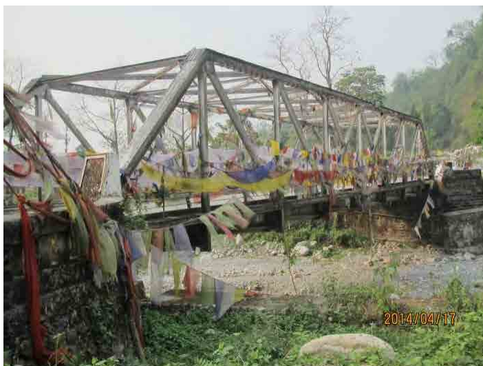
写真-15 橋梁調査 2014年4月15日～20日 B-1.Passang zam 橋
