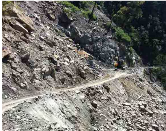
<図 7-5> 国道 4 号線の斜面崩壊地点の状況
