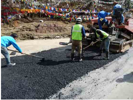
<図 4-21> CDCL による舗装オーバーレイの様子（ペレラ峠）
