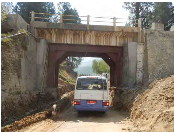
写真-4 橋梁調査 2014年4月15日～20日 A-1.Semtokha Flyover 橋
