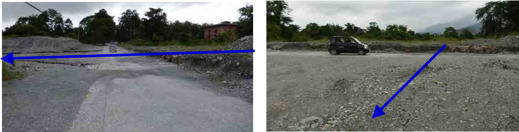
出所：調査団撮影 <図 7-9> 国道 4 号線の状況
