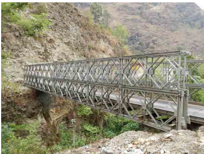
写真-5 橋梁調査 2014年4月15日～20日 A-2.Prakhdrang II 橋
