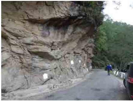
国道1号線上のトマンクリフでの塊状岩盤
