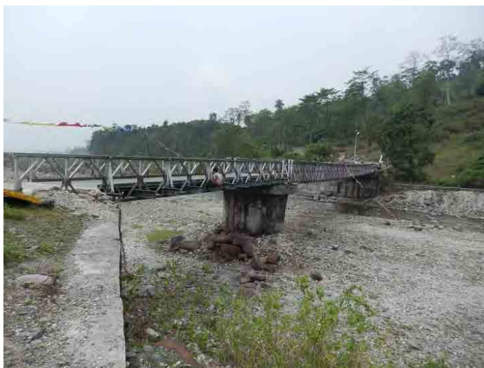
写真-24 橋梁調査 2014年4月28日～30日 C-3.Jitti zam 橋
