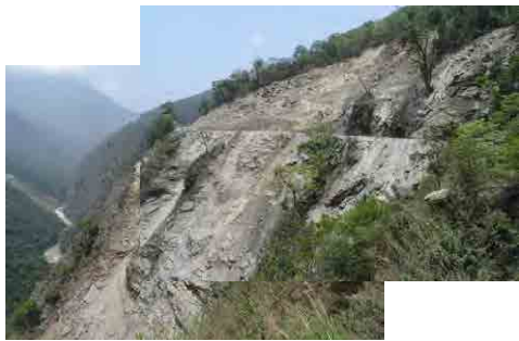
国道4号線上のリオタラ崩壊地（流れ盤）
