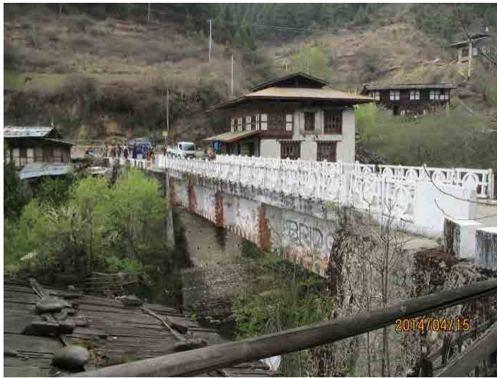
写真-13 橋梁調査 2014年4月15日～20日 A-10.Nikachu zam 橋
