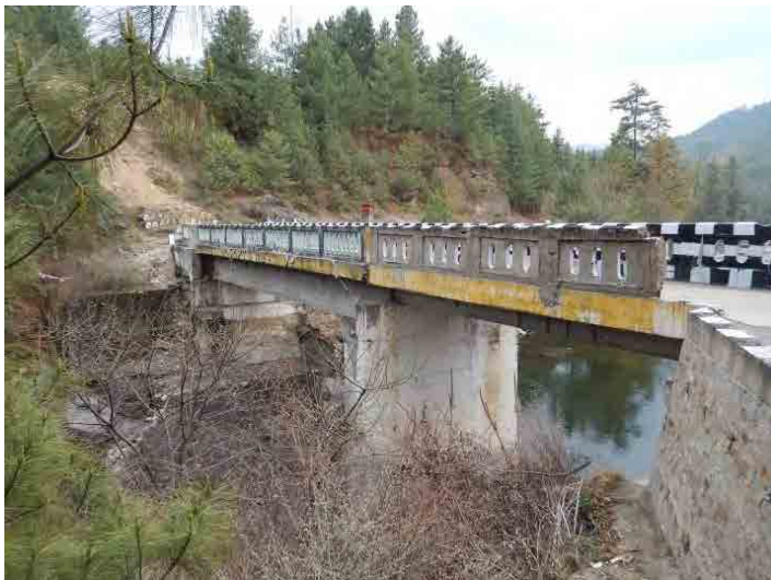
写真-8 橋梁調査 2014年4月15日～20日 A-5.Tangchu zam 橋
