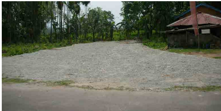
出所：調査団撮影（ゲレフ市内側から計画中心線を撮影） <図 7-10> 南部東西回廊の未接続区間の状況（マオコラ橋アプローチ部）
