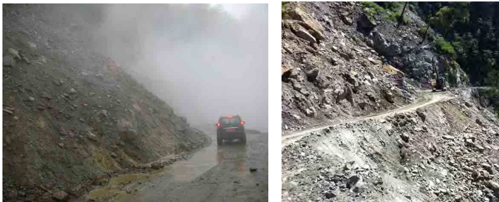
＜図 6-4＞国道 4 号線の斜面崩壊の様子
