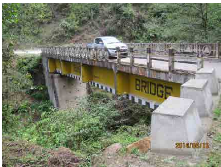
写真-21 橋梁調査 2014年4月15日～20日 B-7.Telegangchu zam 橋
