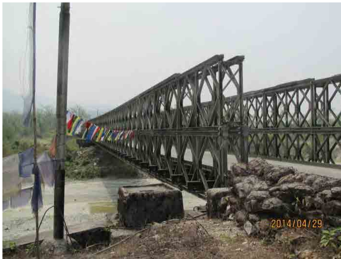
写真-23 橋梁調査 2014年4月28日～30日 C-2.Dramzang zam 橋
