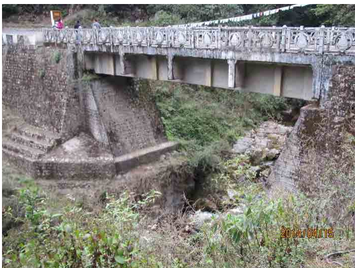
写真-12 橋梁調査 2014年4月15日～20日 A-9.Nangni zam 橋 (Za lamchu 橋)
