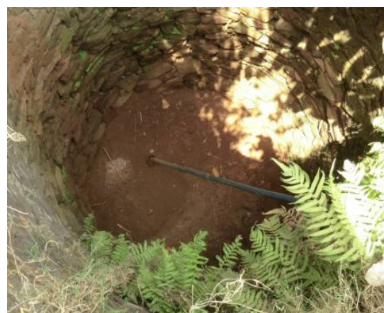
掘抜き井戸中の管井戸
