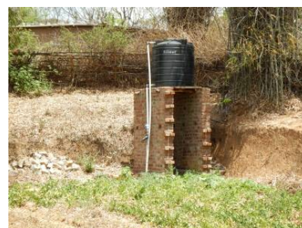
煉瓦製サポートとタンク
