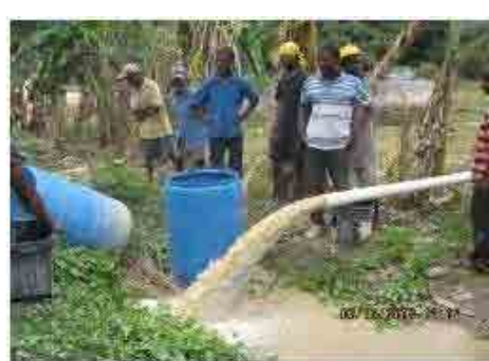
Photo 12 : Nettoyage après le forage d'essai
