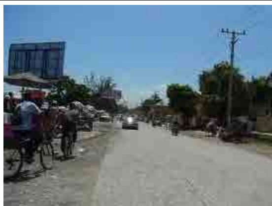
Photo 4 : Section prévue pour la pose de conduites de gros diamètre qui permettront de distribuer l'eau vers la ville (ancienne RN2). La route est goudronnée, le trottoir n'a pas de revêtement.
