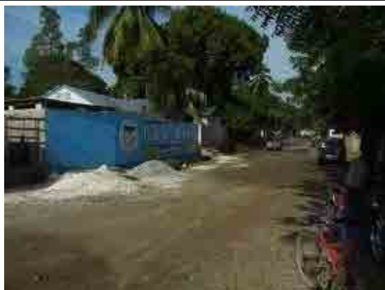
Photo 3 : Section prévue pour la pose de conduites de gros diamètre qui permettront de distribuer l'eau vers la ville. La route n'a pas de revêtement.
