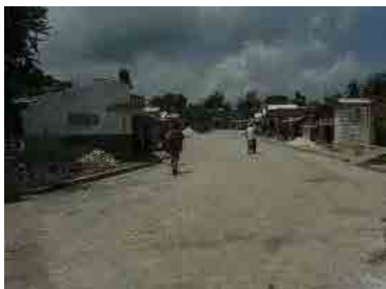
Photo 5 : Route revêtue de pavés autobloquants en 2012 dans le cadre du Projet de réhabilitation des routes urbaines de la JICA (à gauche) et état des caniveaux (à droite).
