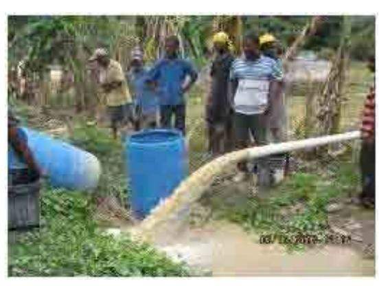
写真-12：試掘井戸掘削後の洗浄。
