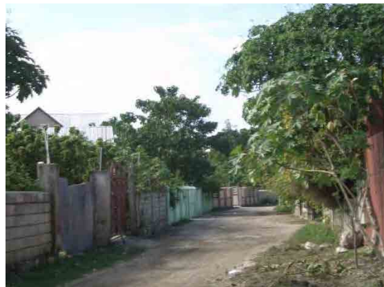
写真-8：新興住宅地であるシャチュレー地区における道路状況（未舗装）。
