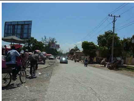
写真-4：市街地へ配水するための大口径配水管を敷設する予定の区間（旧国道2号）。車道部はアスファルト舗装、歩道部は未舗装。
