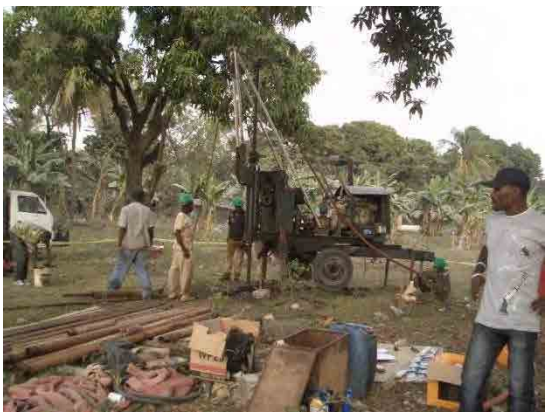
写真-11：高架水槽建設予定地での土質調査状況。
