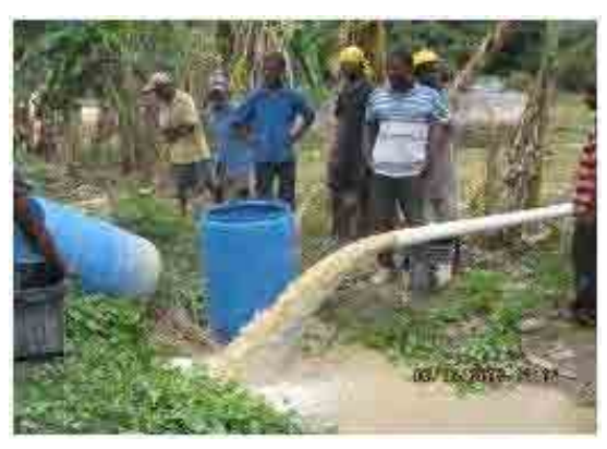
写真-12：試掘井戸掘削後の洗浄。
