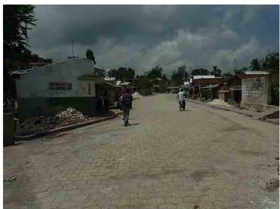
写真-5：JICA 道路プロジェクトにより 2012 年度に施工されたインターロッキングブロック道路（左）および排水路暗渠（右）の状況。
