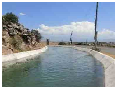
Arzni-Shamiram 水路(改修後)
