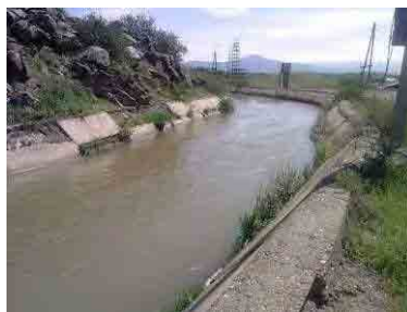
Arzni-Shamiram 水路(改修前)
