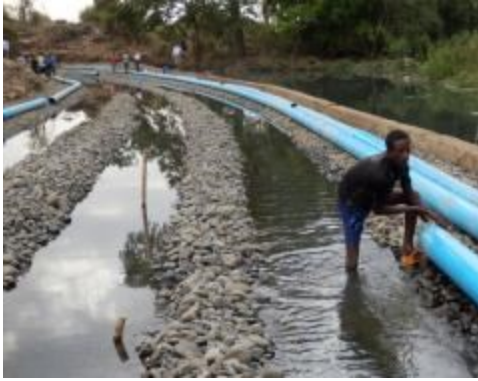
写真 3-2 Tikur Wuha Spring 工事中 (2月)
