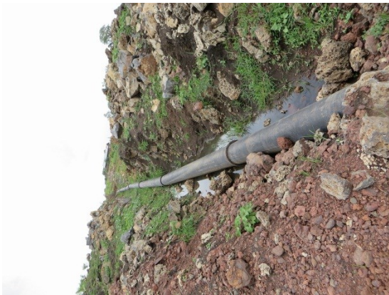
Part A で建設された湧水送水管 (Kotita 配水池へ) (管周りの岩が取り除かれておらず直線に配管されていない。右は湿地帯における施工)
