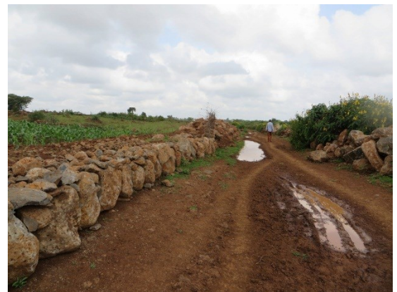
湧水送水管路沿いのアクセス道路整備 (掘削された岩が積みされている)
