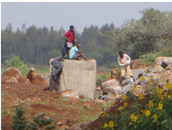
湧水送水管の空気弁設置工事
