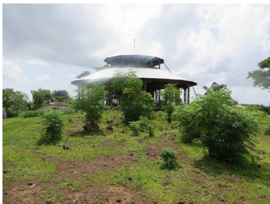
Yibab 配水池予定地近辺
