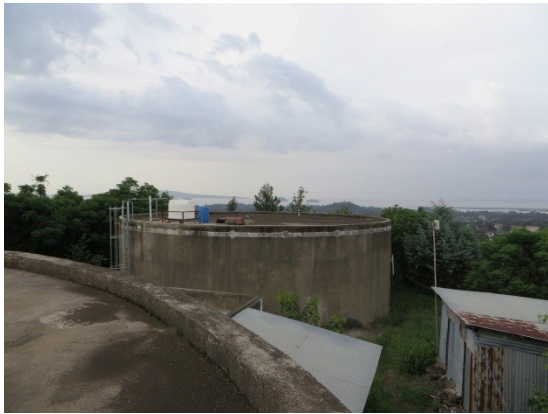
既存配水池 (Kotita)
