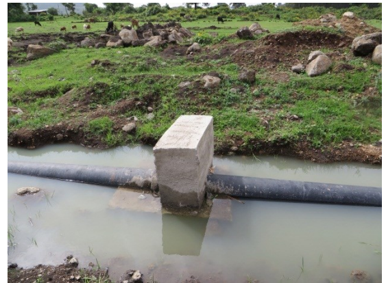
Part A で建設された湧水送水管 (Kotita 配水池へ) (管周りの岩が取り除かれておらず直線に配管されていない。右は湿地帯における施工)
