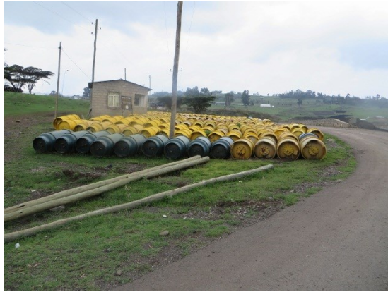
Legedadi 浄水場 (塩素タンク)
