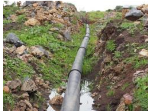
写真 3-5 送水パイプ敷設完了
