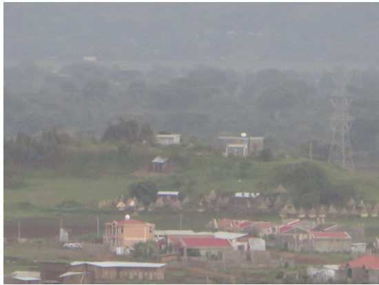
既存配水池 (Kotitina) と近辺
