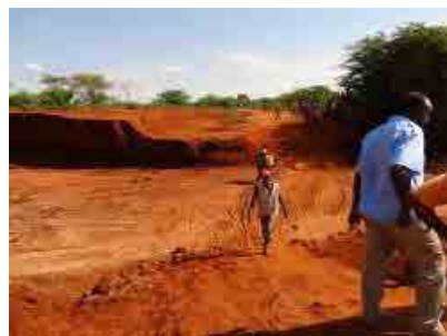
上記と同じ構造のコンクリートの橋梁がフラッシュフラッドにより流失
