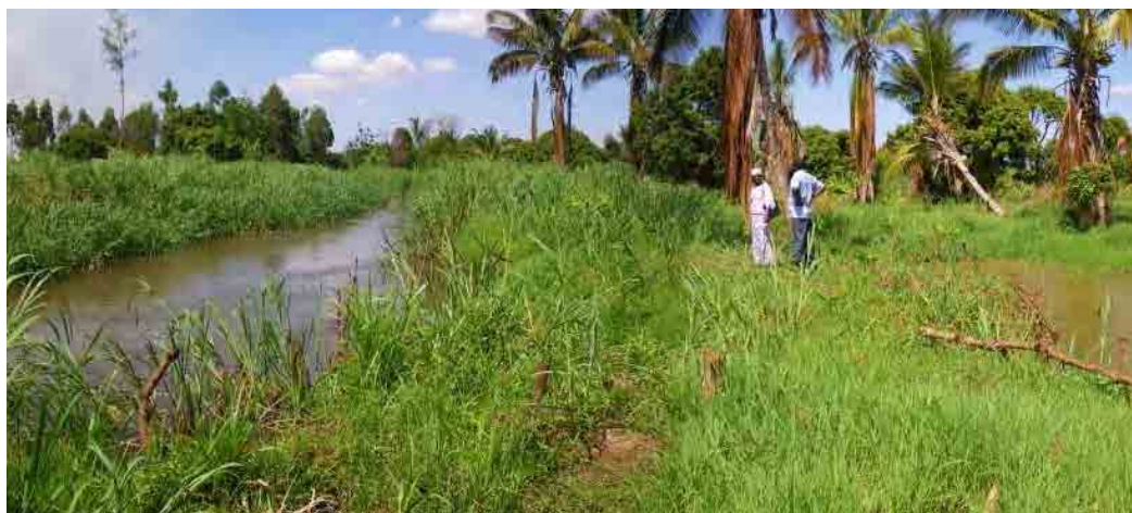
写真 3.2.1 Lumi 川河口付近(川幅が狭く、天井川となっている)
