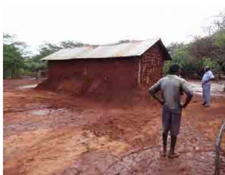
家屋が浸水した後、土盛りした様子
