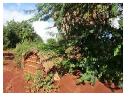
堆積土砂で埋まり、放置されたトイレ
