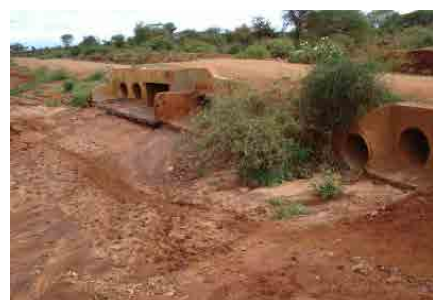
道路を横断する枯れ川に設置された パイプカルバート付きの橋梁
