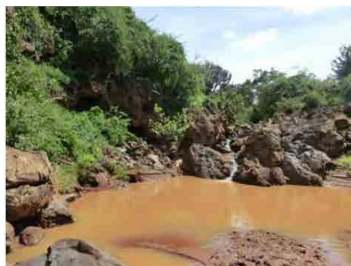
写真 3.2.1 土石流による河道の被害
