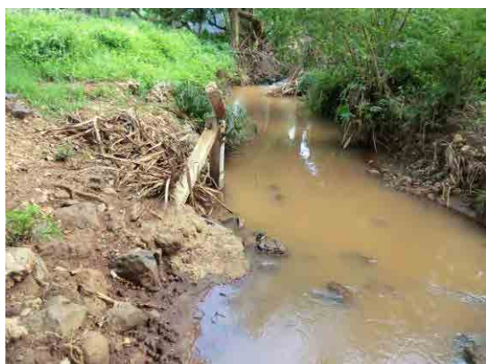
水位観測所番号:5DA04 観測河川: Eastern Marania River 特記: 水位計が折れており、破損している。
