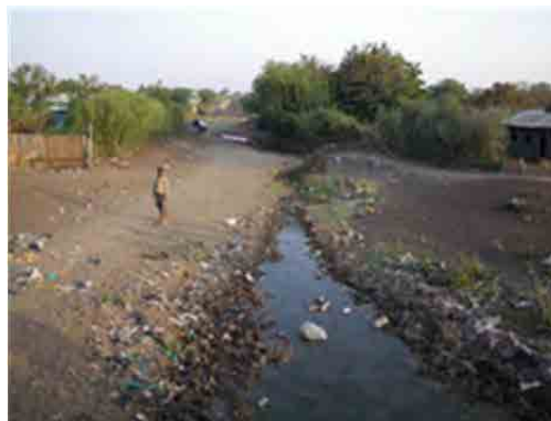
Merire 川の市街地最下流部(上流を望む) 左岸側の小屋は違法居住者の家屋
