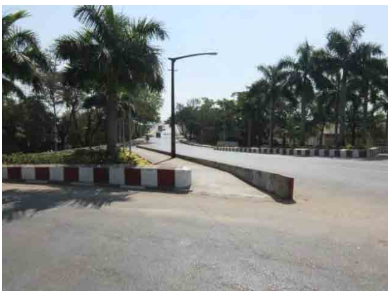
既設タケタ橋道岸側接続道路、インターチェンジ
