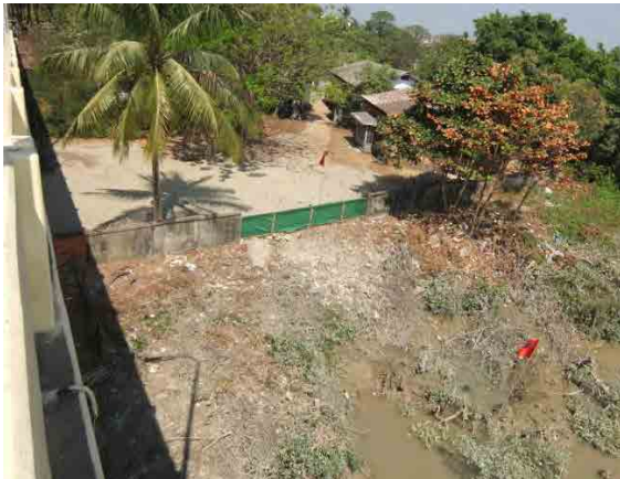
新タケタ橋右岸側架橋予定地点（既設タケタ橋橋上より）
