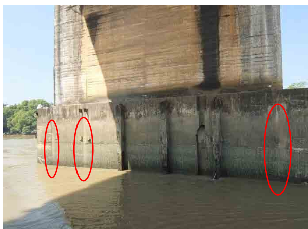
図 3.3.10 既設タケタ橋に設けられた防舷材の脱落
