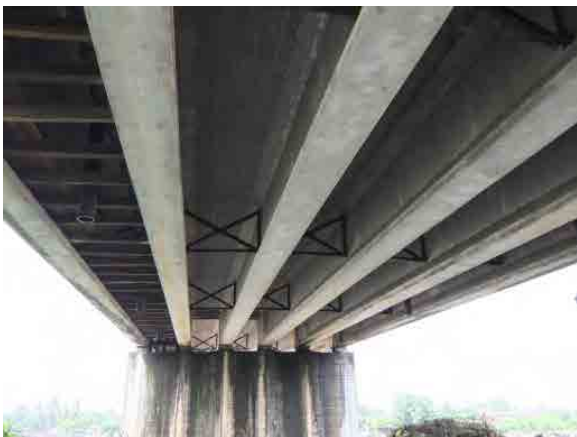
既設タケタ橋アプローチ部の下面。PC 桁は伸縮装置・支承を除き健全
