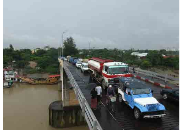
既設タケタ橋の渋滞状況（午前 10 時頃）
