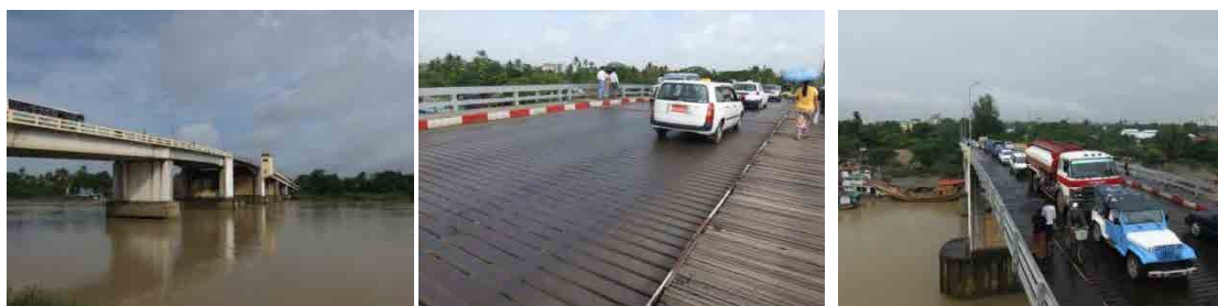
タケタ橋全景
