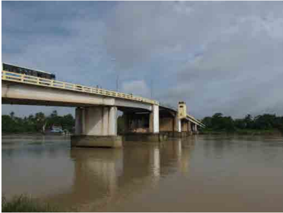
既設タケタ橋全景（左岸上流側より）
