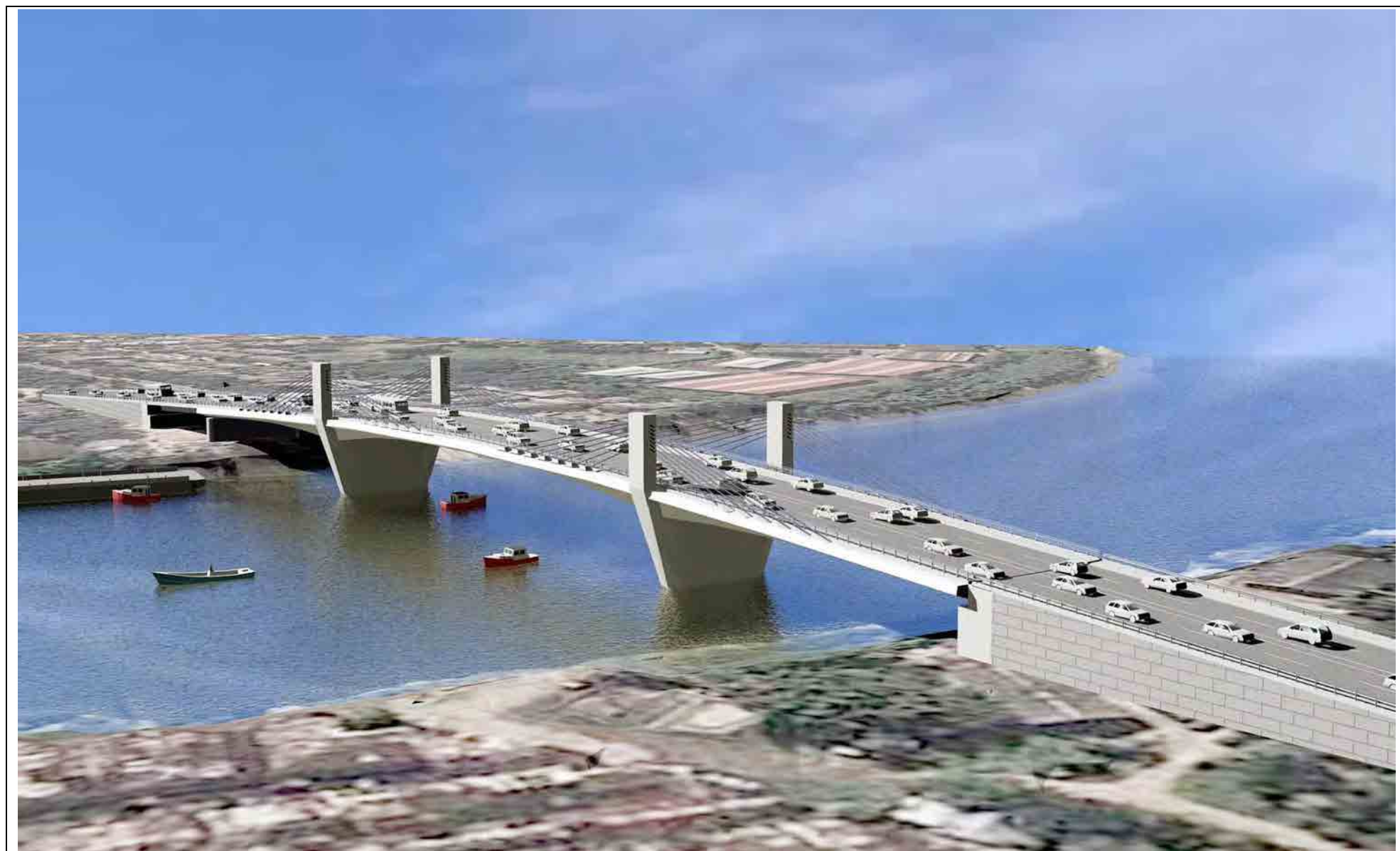
新タケタ橋 (PC エクストラロード橋)
