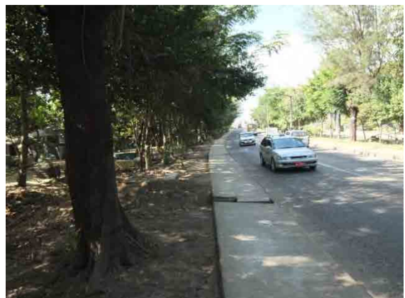
既設タケタ橋左岸側接続道路
