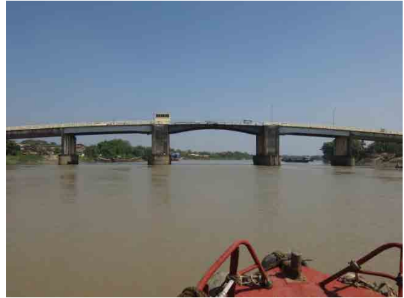
既設タケタ橋（船上下流側より）
