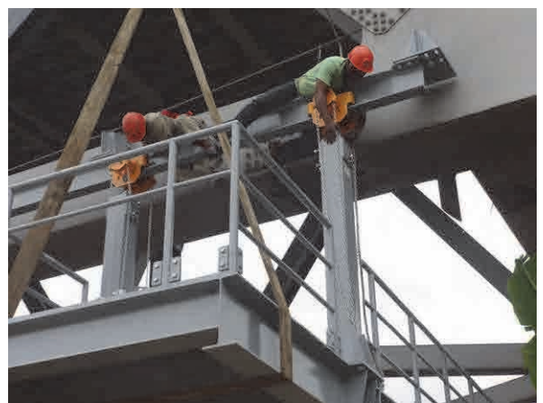
Assemblage du corps du chariot avec le système de motorisation
