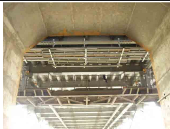
(15) Caillebotis provisoire pour inspection des joints de dilatation (Côté A2)
