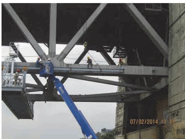
Mise en place des rails sur le tronçon sans rail
