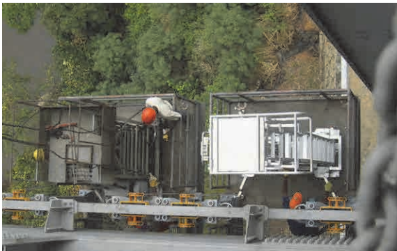
Mise en place du support de travail à élévateur sur le chariot d'inspection existant
