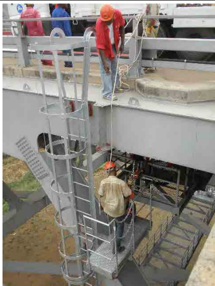
(12) Nouvelle échelle élévatrice (Côté A1)
