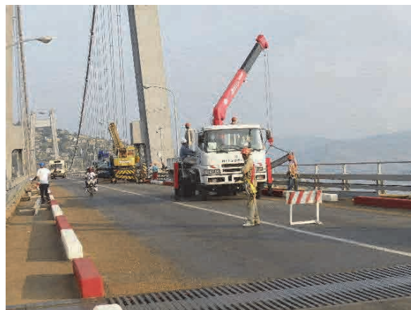
Pose des supports et des rails aux emplacements désignés
