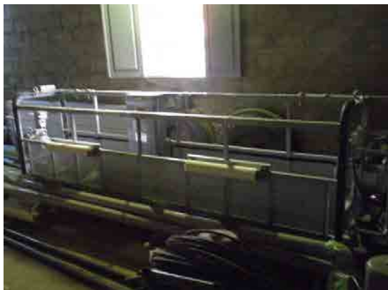
(10) Nouvelle nacelle d'inspection du pylône (P1)
