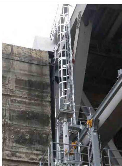
(13) Nouvelle échelle élévatrice (Côté A2)
