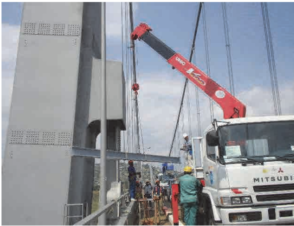
Levage des rails par UNIC
