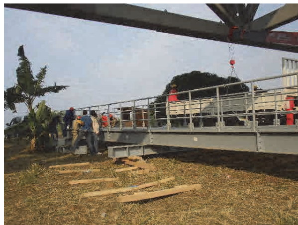
Montage du garde-corps, du matériau de plancher et des suspentes
