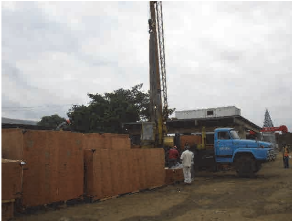
État actuel de l'aire de stockage provisoire des matériels et équipements fournis (Entrepôt de l'OEBK)
