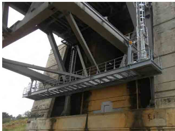
(4) Chariot d'inspection de la surface inférieure de la travée latérale côté A1
