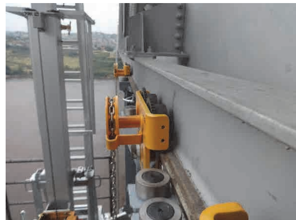
Système de motorisation et dispositif anti-oscillation après remplacement
