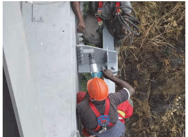
Serrage final des boulons des supports et des rails
