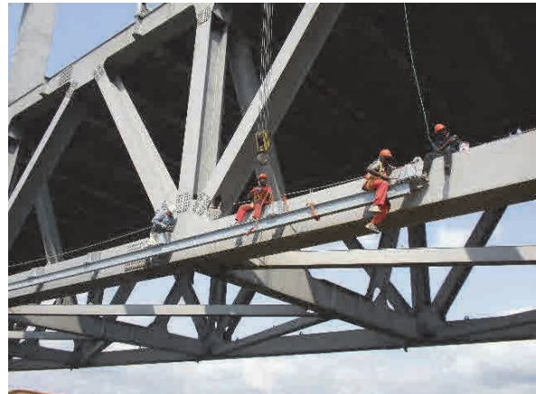
Travaux de mise en place des rails
