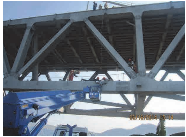
Mise en place des supports avec le camion élévateur
