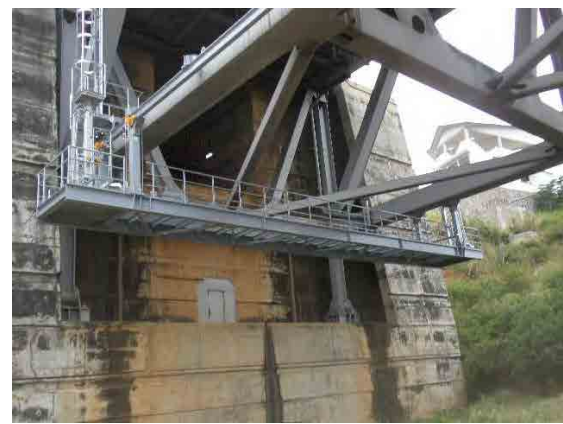
(5) Chariot d'inspection de la surface inférieure de la travée latérale côté A2
