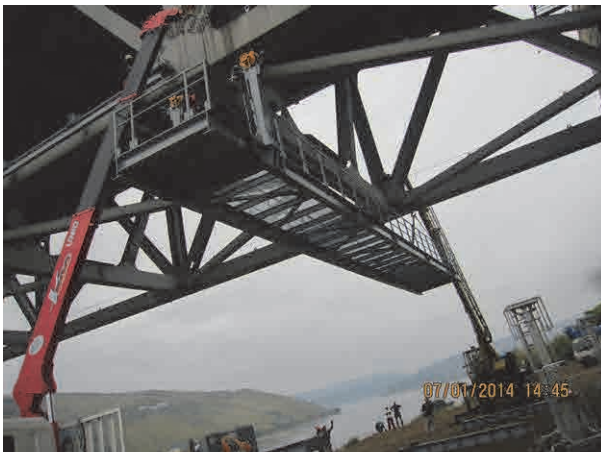
Suspension du corps du chariot d'inspection
