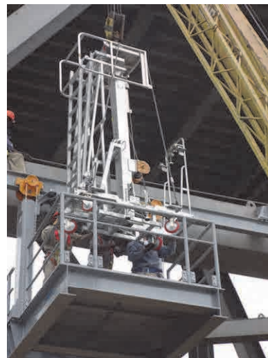
Descente jusqu'au chariot d'inspection
