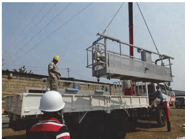
Transport des pièces de la nacelle à partir de l'entrepôt de l'OEBK
