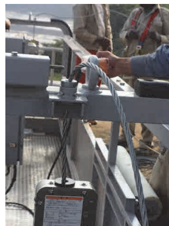
Mise en place du câble de levage
