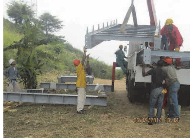
Pose des pièces dans l'aire de montage provisoire et montage en site
