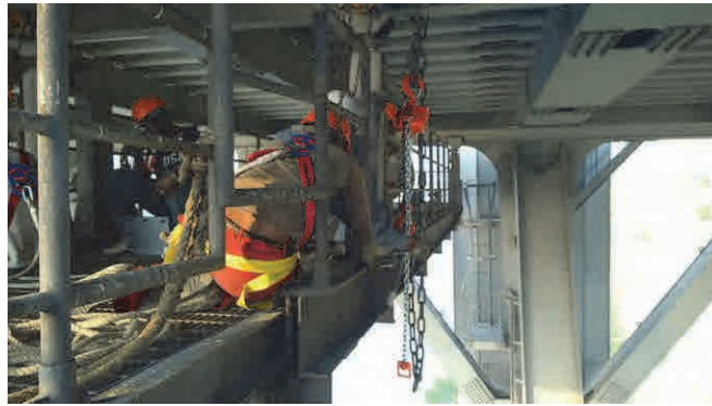
Suspension provisoire du chariot d'inspection existant par palan à chaîne
