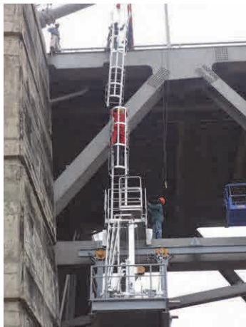
Mise en place de la partie supérieure de l'échelle
