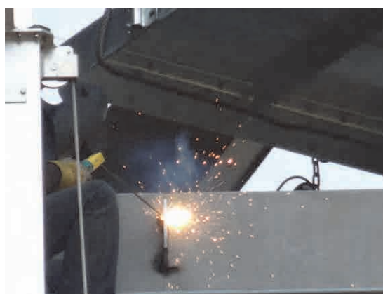
Soudure des pièces de l'échelle sur le corps du pont
