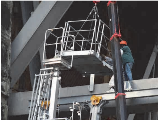
Mise en place du palier inférieur
