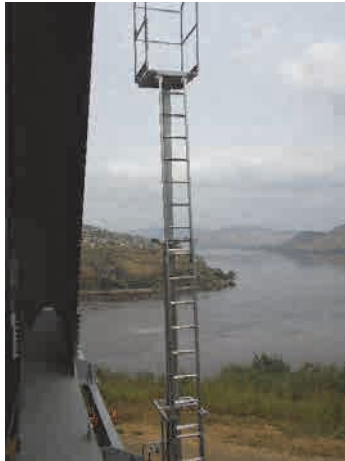
Impression d'instabilité car le support n'est que d'un seul côté
