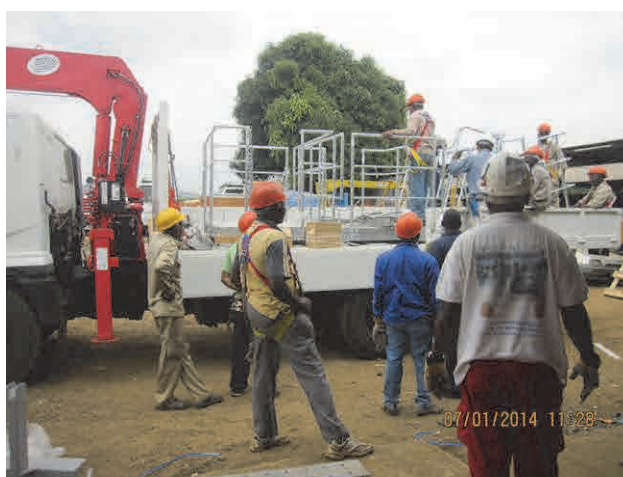
Montage à l'entrepôt aux dimensions permettant le transport jusqu'au site de mise en place
