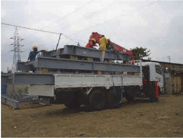
Transport vers le site des pièces montées provisoirement dans l'entrepôt
