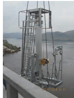
Descente du nouveau support jusqu'au chariot d'inspection par UNIC
