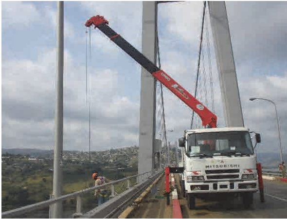
Mise en place des supports avec l'UNIC
