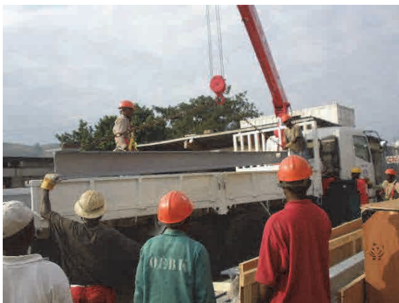
Transport des rails avec l'UNIC jusqu'au pont
