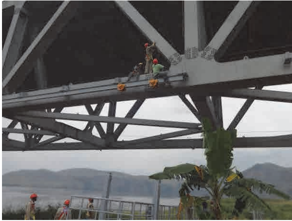
Mise en place du système de motorisation à partir du tronçon sans rail
