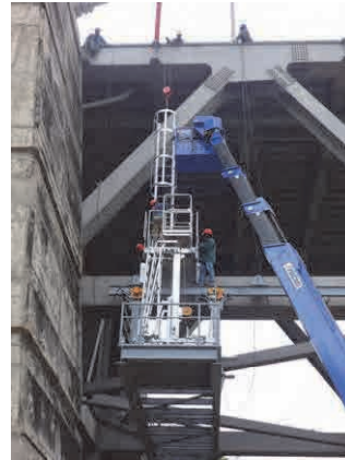
Mise en place de la partie inférieure de l'échelle
