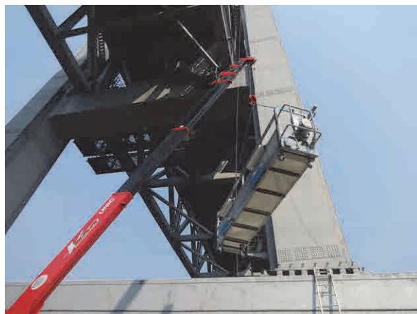
Pose provisoire de la nacelle sous le pylône
