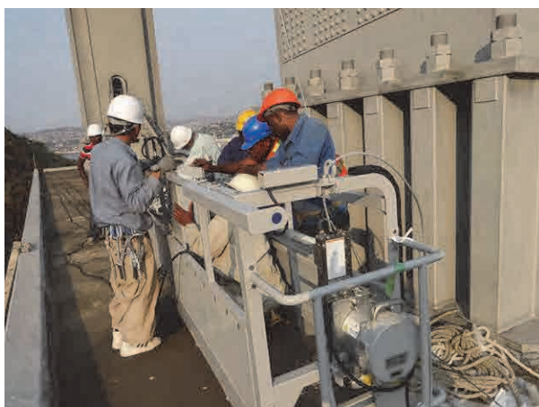
Montage de la nacelle sous le pylône
