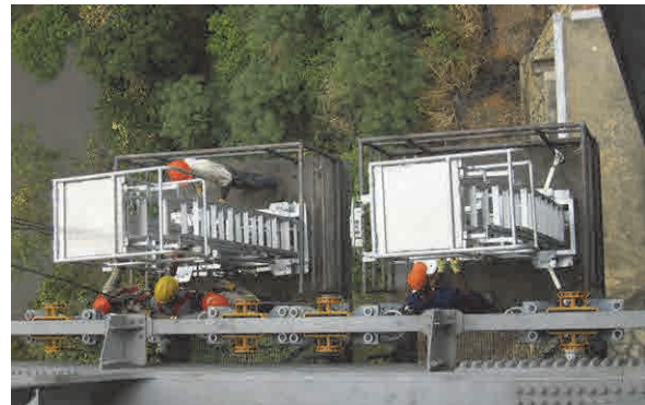
Pose sur le côté du support à partir de l'espace du chariot d'inspection
