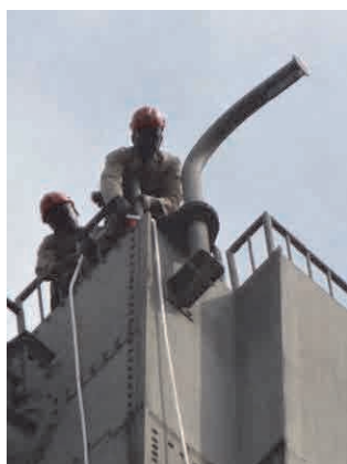
Inspection des pièces de suspension sur le pylône
