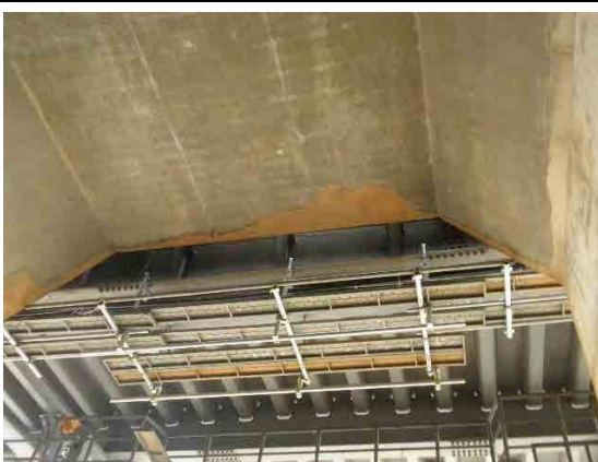
(14) Caillebotis provisoire pour inspection des joints de dilatation (Côté A1)
