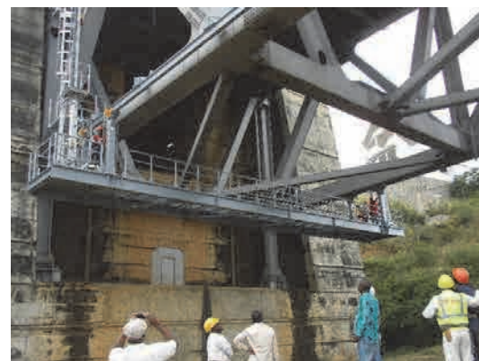
Inspection finale en présence du Directeur général de l'OEBK (Vérification du fonctionnement du nouveau chariot d'inspection de la surface inférieure de la travée latérale du côté A2)
