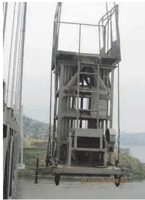
Retrait du support de travail à élévateur existant
