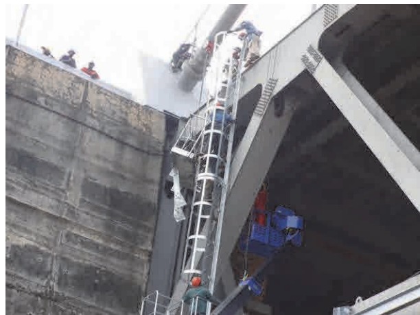
Mise en place du palier intermédiaire
