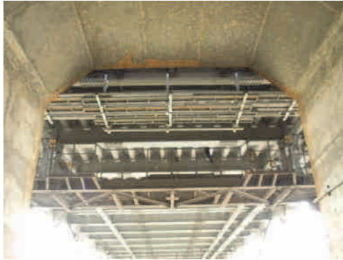
Caillebotis provisoire vu de l'ancrage (chemin de fer)
