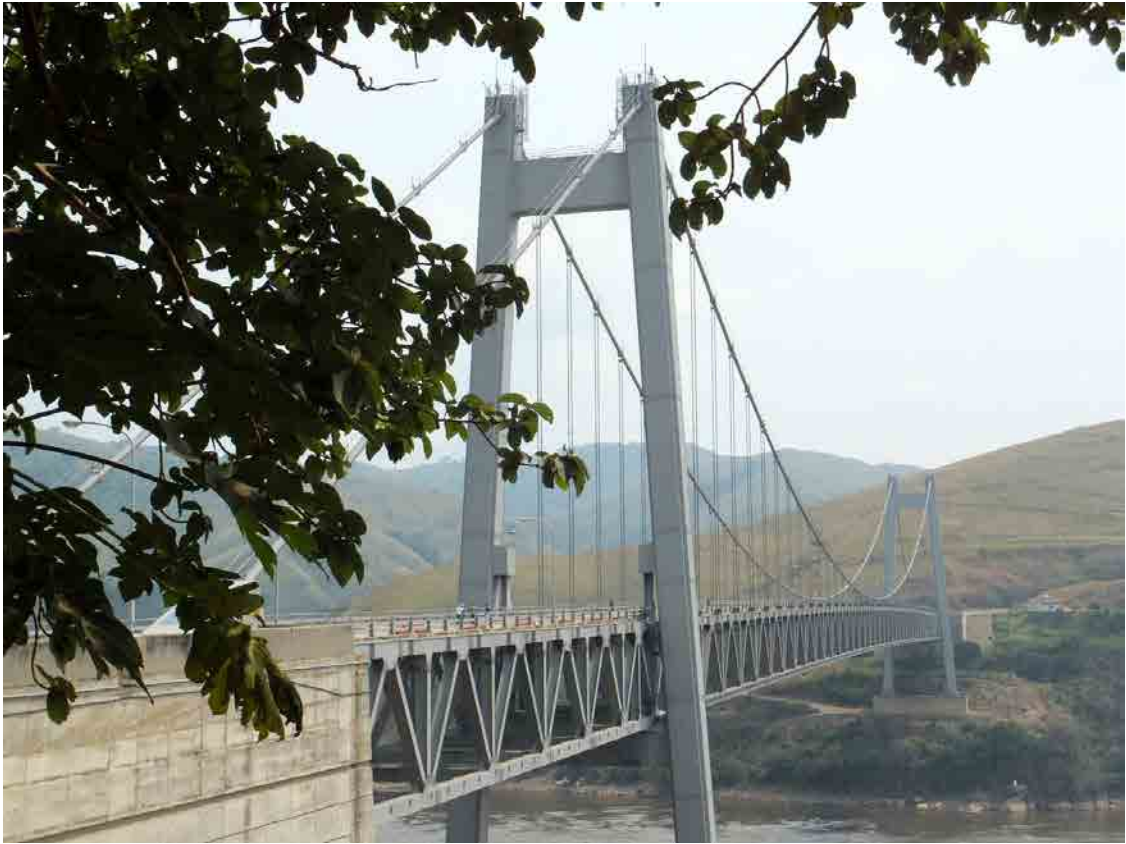
(1) Vue d'ensemble du Pont Matadi
