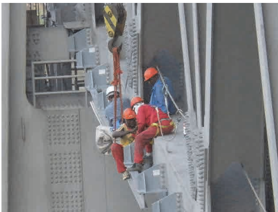
Travaux de mise en place des rails
