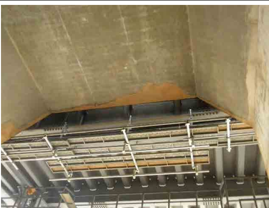
(14) 伸縮装置点検用仮設足場 (A1 側)
