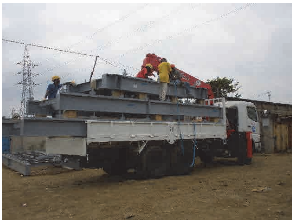
ガレージ仮組した部材を現場へ運搬
