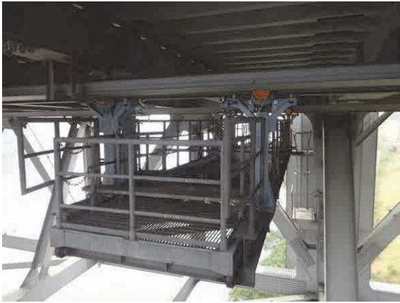
駆動装置、揺れ止め及び吊部材交換後の 既設検査車
