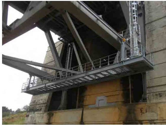
(4) A1側サイドスパン下面点検検査車
