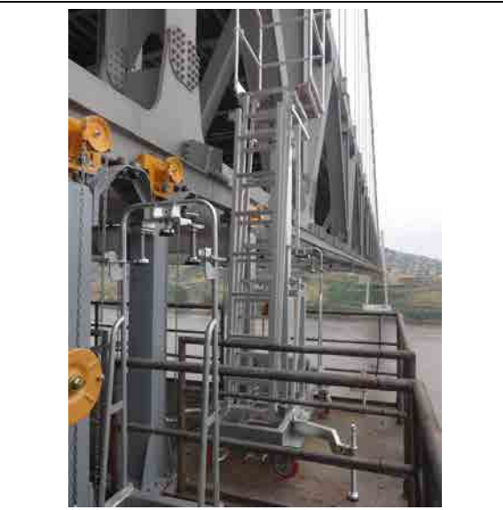
(9) 既設下面点検検査車駆動装置 (A2側)
