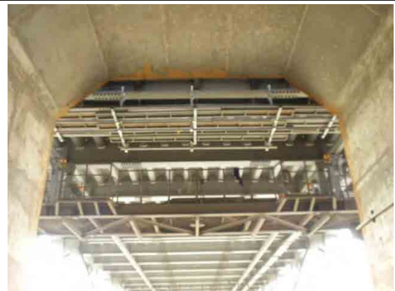
(15) 伸縮装置点検用仮設足場 (A2 側)
