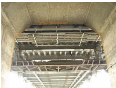
アンカレッジ側（鉄道部）から見た仮設足場
