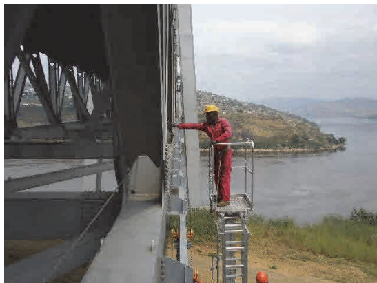
検査車の台座に合わせ固定したため、作業台から手を伸ばしてやっと補鋼桁側面に届く程度である
