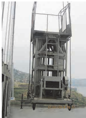
既設昇降作業台撤去
