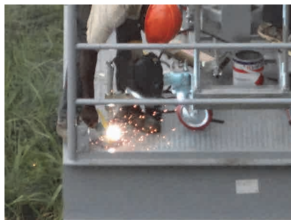
昇降作業台のアウトリガーを溶接にて固定
