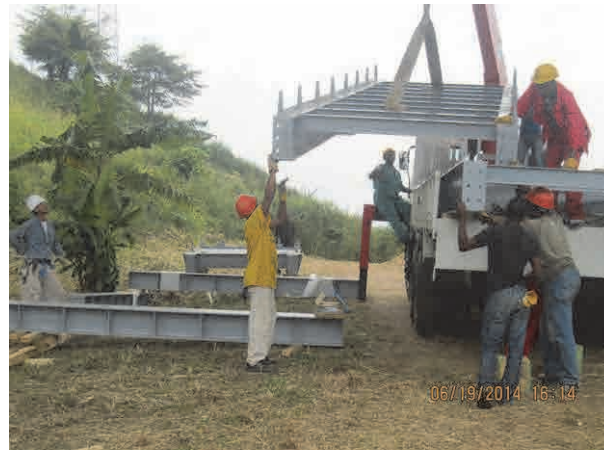
仮設組立台上に部材を置き、路地組実施
