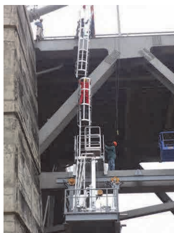
梯子上部を設置
