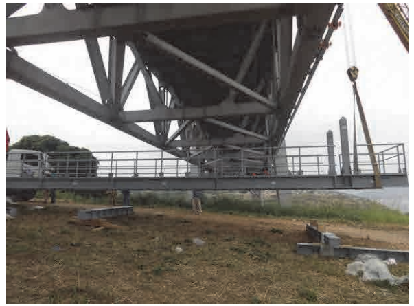
検査車本体吊上げ
