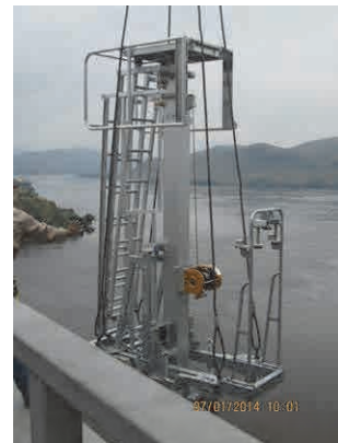
新昇降作業台をユニックで検査車まで降下
