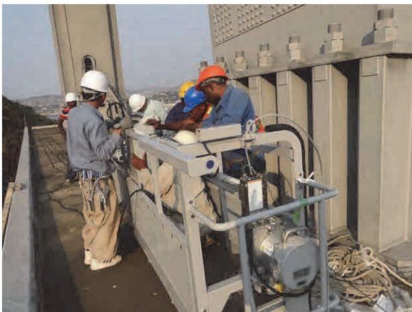
塔の下にてゴンドラの組立
