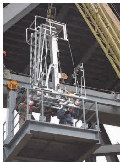
検査車に吊下し
