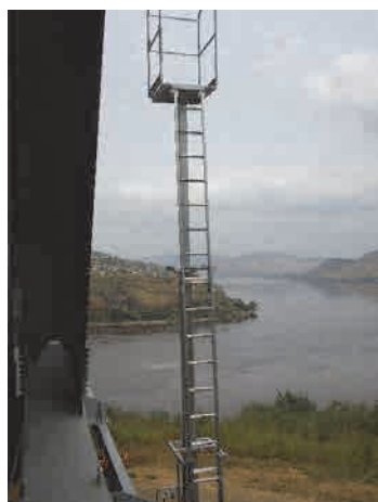
新昇降作業台を一本柱のため不安定感ある
