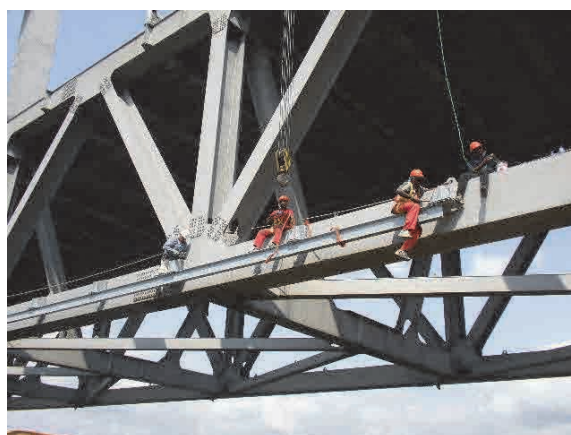
レール取付作業状況
