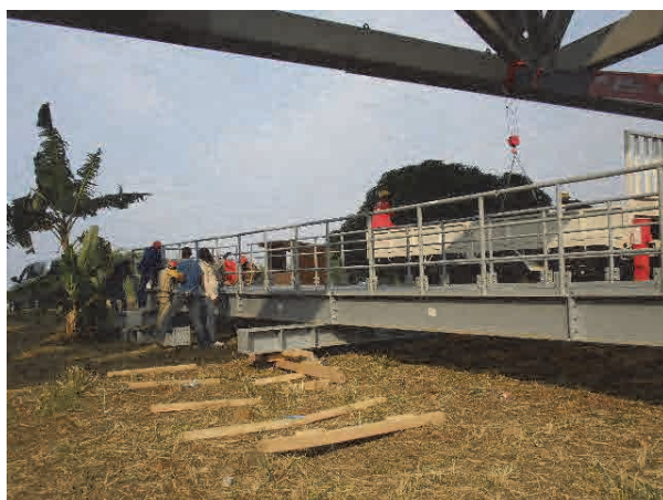
手摺、床材、吊材等の組立
