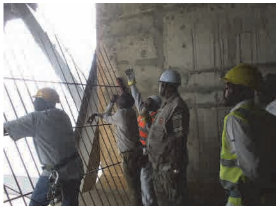
OEBK 総裁による完了検査 (アンカレッジ内部より A1 側既設上面点検 検査車の動作確認)
