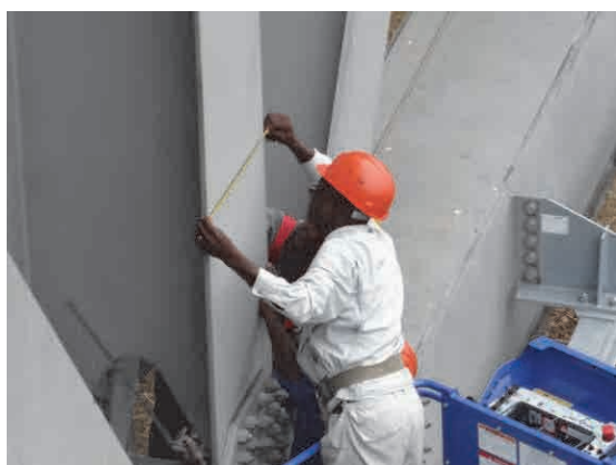
梯子取付部材の位置出し
