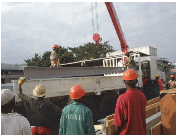
ユニックを使いレールを橋梁に運搬
