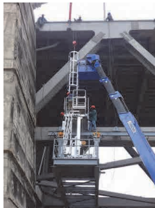
梯子下部を設置
