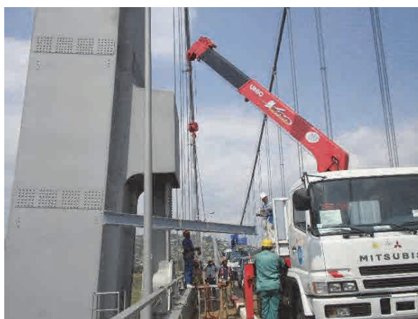
ユニックによるレール部材の吊下げ
