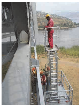
検査車の台座に合わせ固定したため、作業台から手を伸ばしてやっと補鋼桁側面に届く程度である
