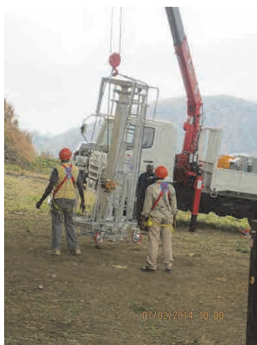
ユニックにて昇降作業台を吊上げる
