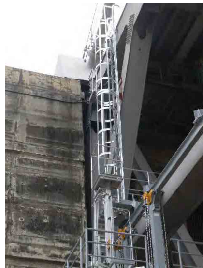
(13) 新設昇降梯子 (A2 側)
