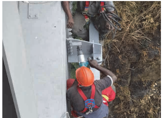
ブラケット及びレールボルトの本締め
