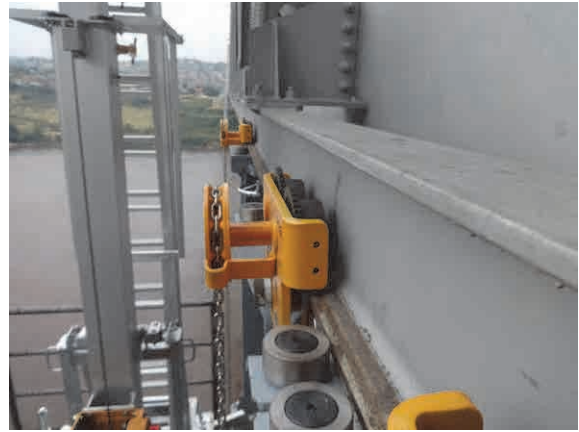
交換後の駆動装置、揺れ止め部
