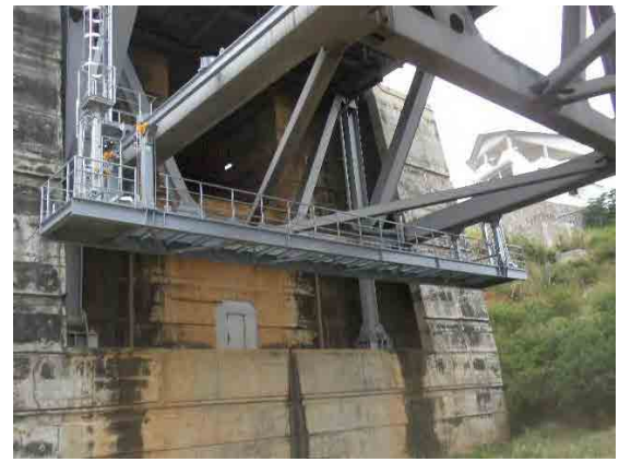
(5) A2側サイドスパン下面点検検査車
