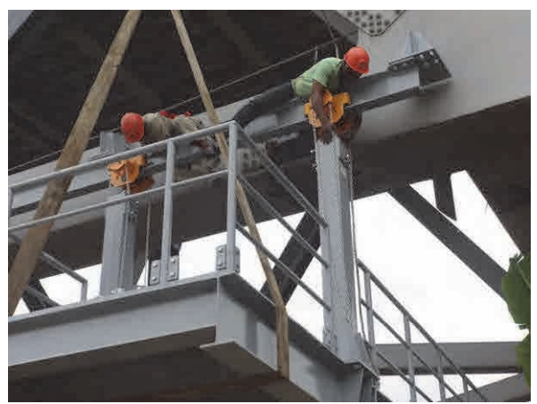
検査車本体と駆動装置の接合
