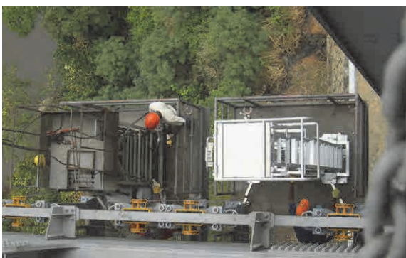
既設検査車上に昇降作業台を設置
