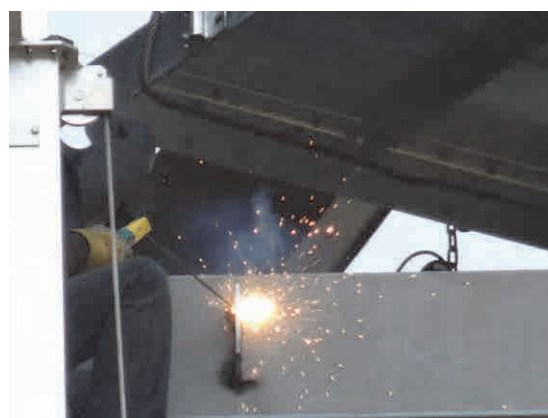
梯子取付部材の橋梁本体への溶接
