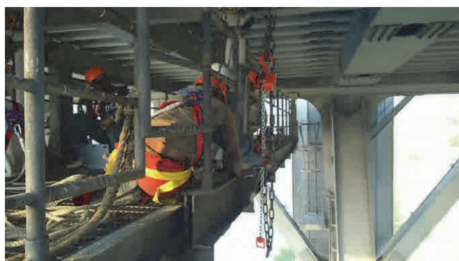
チェーンブロックにて既設検査車の仮吊
