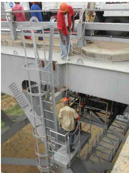
(12) 新設昇降梯子 (A1 側)
