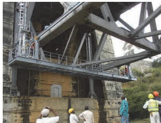
OEBK 総裁による完了検査 (新設 A2 側サイドスパン下面点検検査車 の動作確認)
