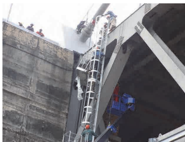
中間踊場を設置
