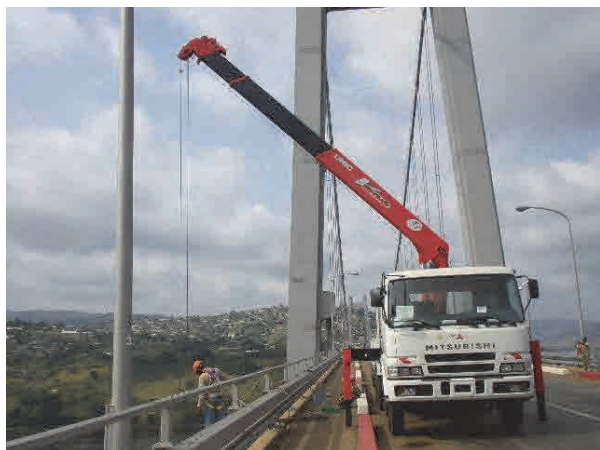
ユニックを使用してのブラケット取付
