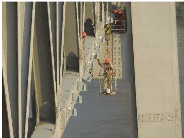
OEBK 吊作業台によるブラケット取付
