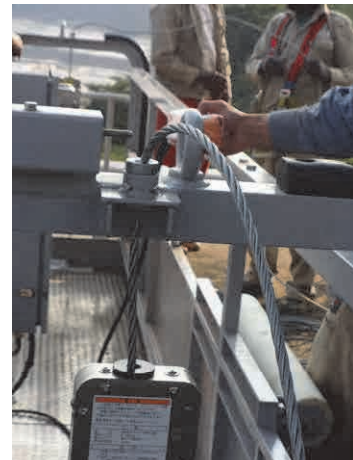
昇降ロープの取付
