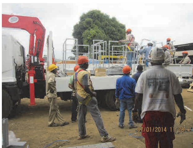
ガレージにて可能な限り組立、設置場所に運搬
