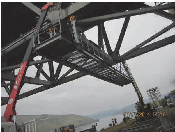
検査車本体吊上げ
