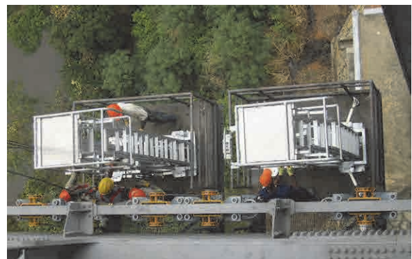
検査車スペースから昇降作業台は横置き
