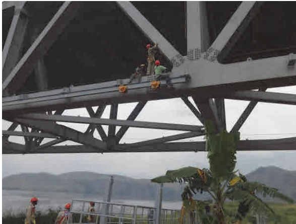
レール未設置区間から駆動装置取付
