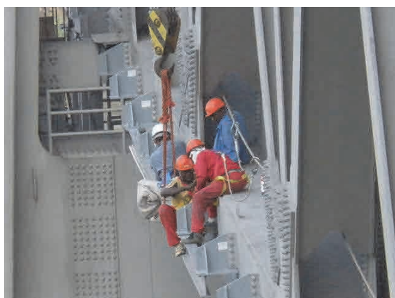
レール取付作業状況
