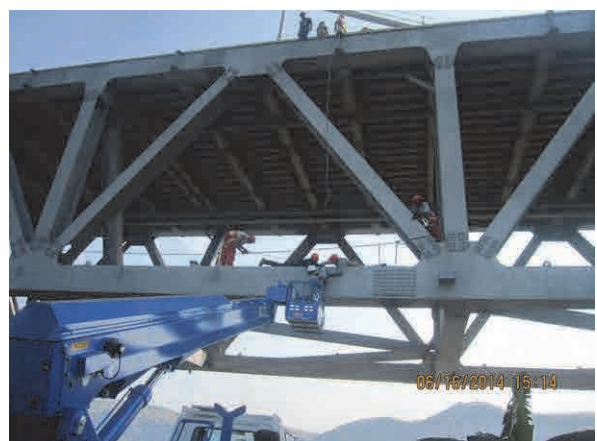
高所作業車を使用してのブラケット取付
