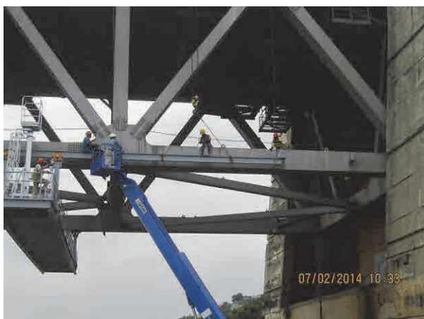
レール未設置区間のレール設置
