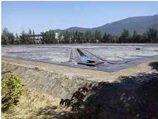
• ソンチャ下水処理場（嫌気性ラグーン）
