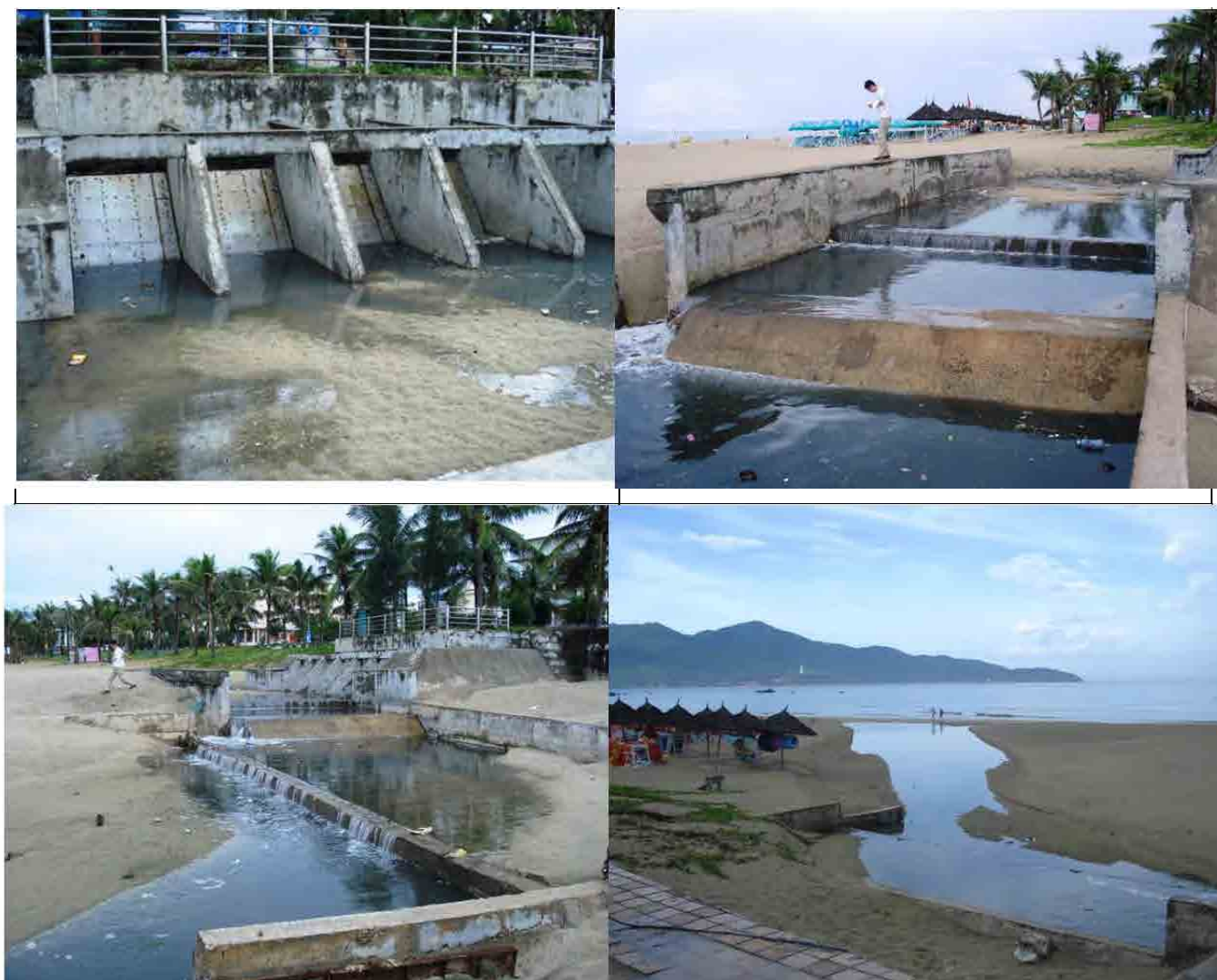
図 2.4 ポンプ場 3 の合流式下水道吐口（My Khe ビーチ, 2012 年 7 月 20 日）
