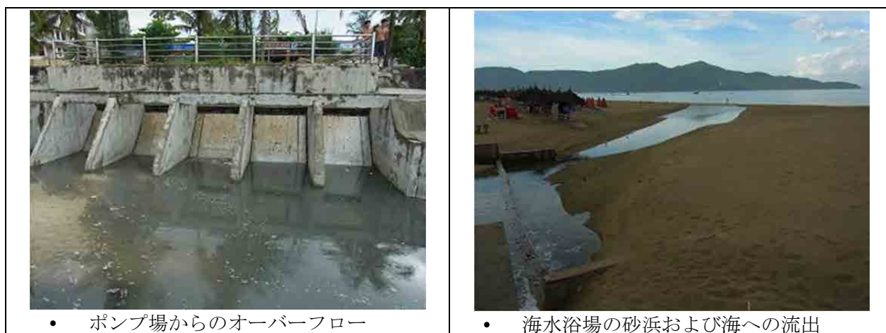
写真 1-2-1 ポンプ場 SPS 3 から沿岸に汚濁物質が流出する様子 (7/21 降雨時)
