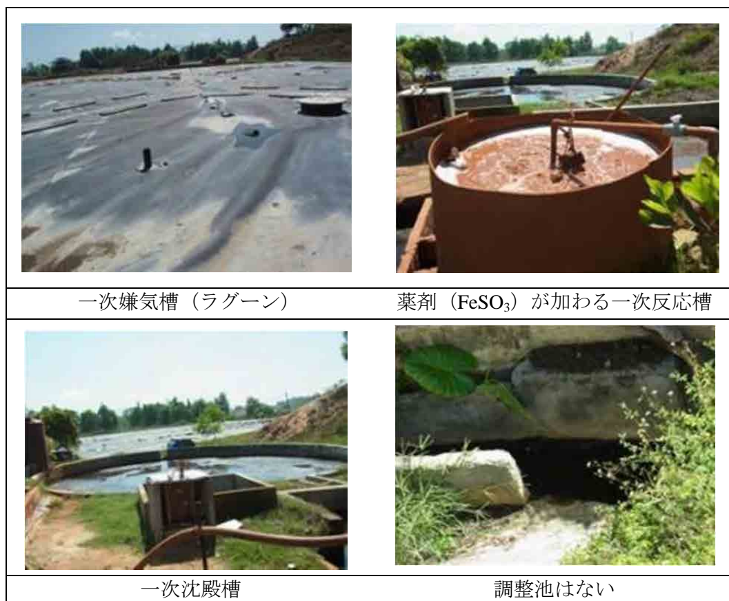
図 2-14: 浸出水処理施設の様子
