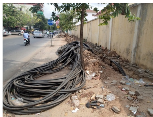
図 8.4-4 地中電線路(工事中)
