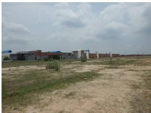
GS5 周辺の空地および建設中の建物
