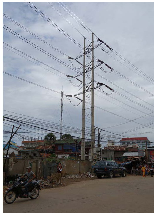
図 7.1-38 115kV_Route3 の現地調査ルート写真
