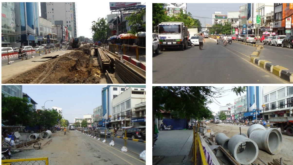
図 4.2-1 下水管理設工事の状況
