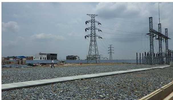
1) 既設変電所内(115kV 母線北側)
