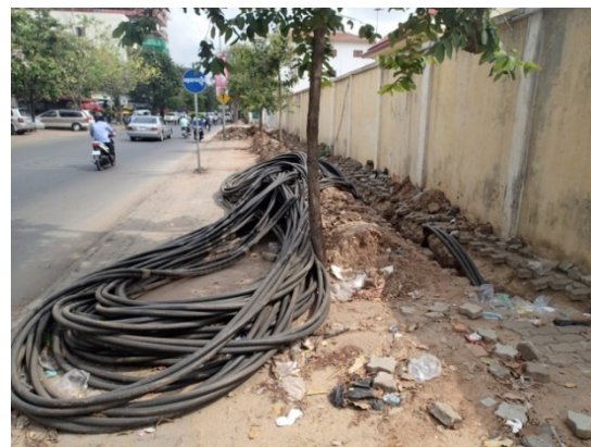
図 8.4-4 地中電線路(工事中)
