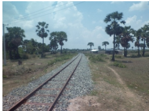
計画ルート上には、線路もある。 (現在、使用されていない。)
