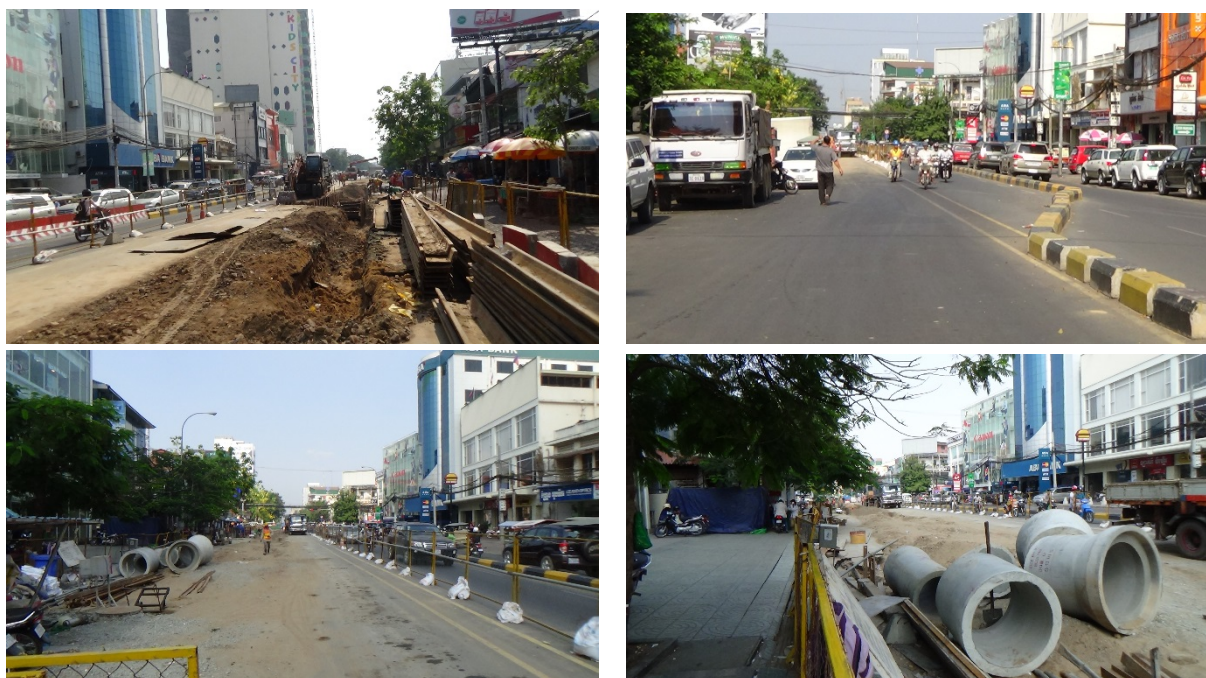
図 4.2-1 下水管理設工事の状況
