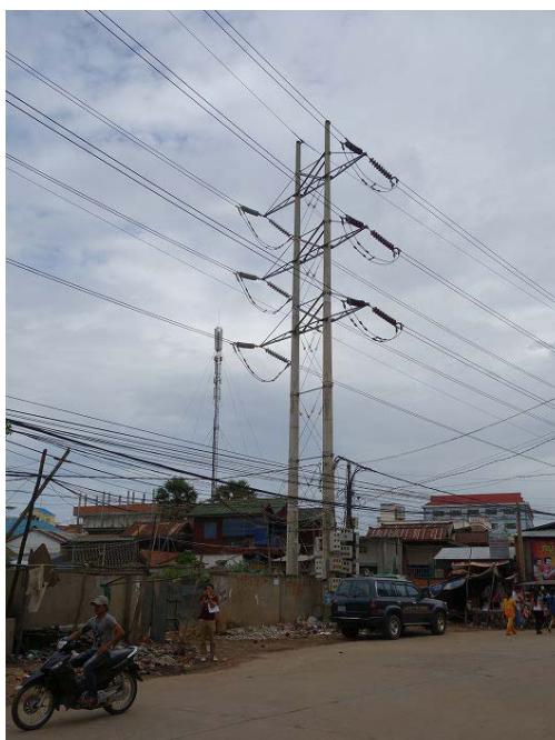
図 4.1-5 OHL_Route7 の分岐コンクリート柱
