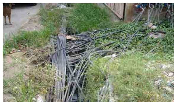
写真-2.2.1 一つのStub-Outに82個の水道メータが設置されている例 [2-39]
