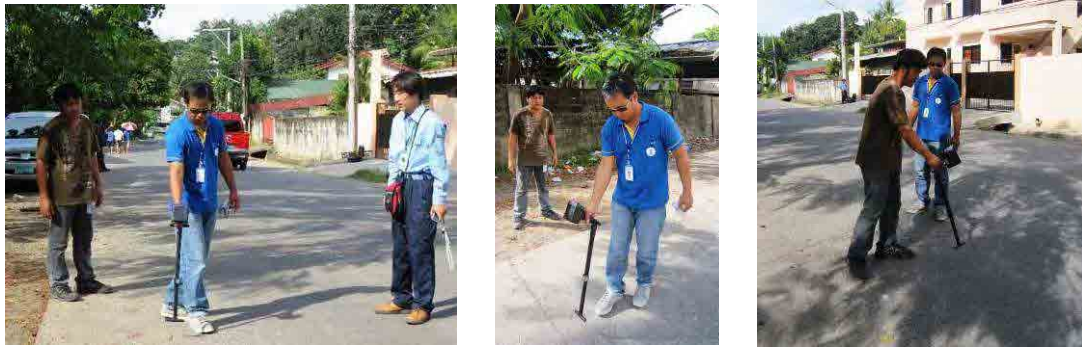
写真-3.5.3 D305 による漏水調査
