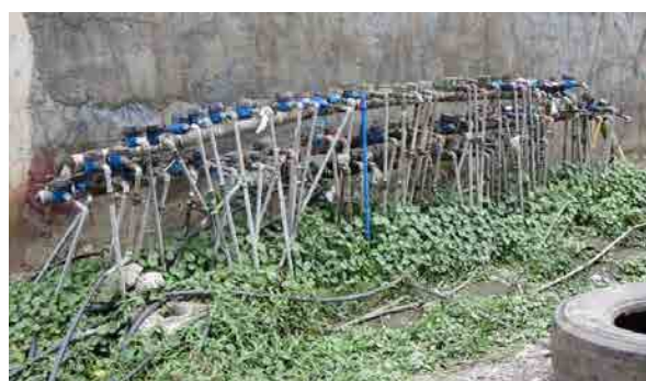
写真-2.2.1 一つのStub-Outに82個の水道メータが設置されている例 [2-39]
