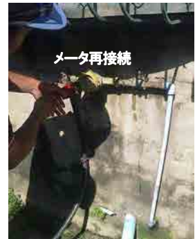
写真-2.2.3 未納断水作業(左2枚)、再接続作業(右2枚) [2-42]
