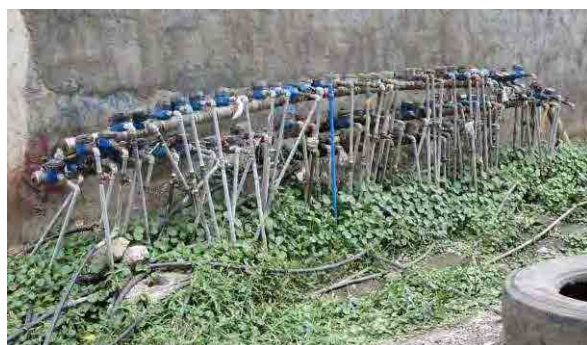
写真-2.2.1 一つのStub-Outに82個の水道メータが設置されている例
