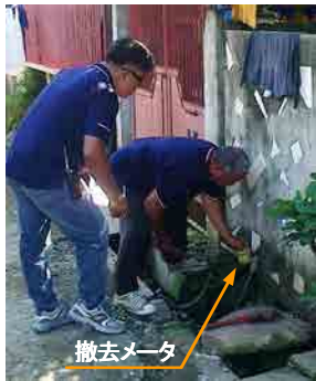
写真-2.2.3 未納断水作業(左2枚)、再接続作業(右2枚) [2-42]
