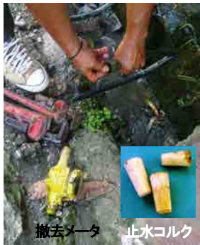
写真-2.2.3 未納断水作業(左2枚)、再接続作業(右2枚) [2-42]
