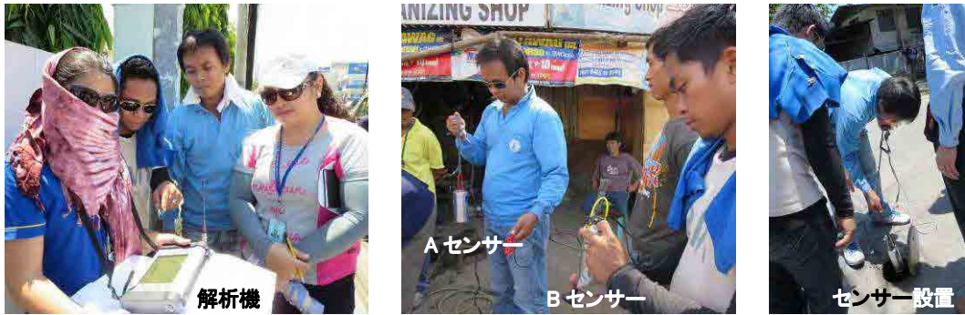
写真-3.5.1 AQUQSCAN 610 による漏水調査
