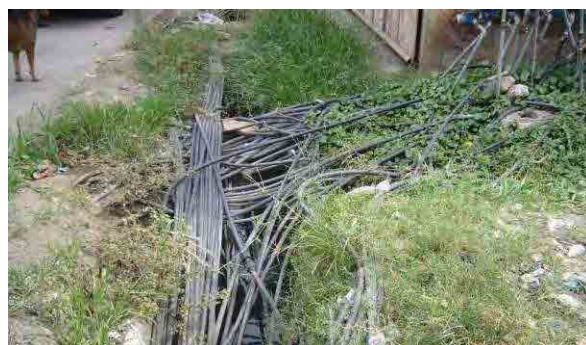
写真-2.2.1 一つのStub-Outに82個の水道メータが設置されている例
