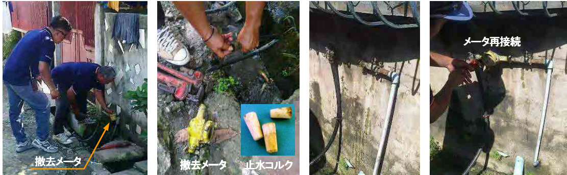
写真-2.2.3 未納断水作業(左2枚)、再接続作業(右2枚)
