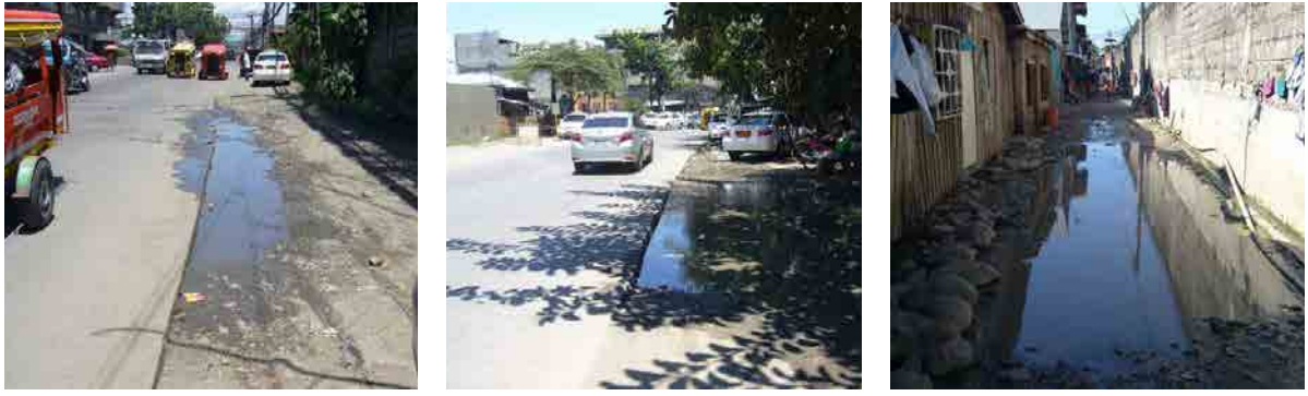
写真-3.1.2 市内の水溜り発生箇所の状況 [3-2]
