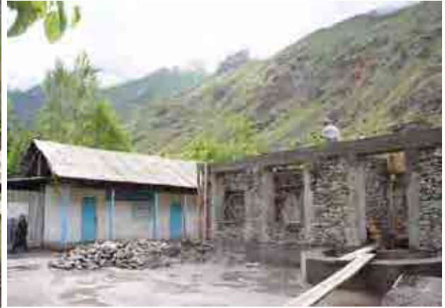
ダルバズ県Sangevni Daroz村小学校増設現場（4教室）
