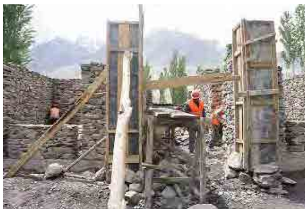
シュグナン県Vozom村メディカルポイント建設現場 (3診療室)
