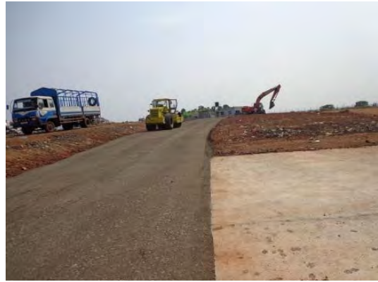
雨季用アクセスロードの建設
