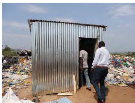
図 4-35 修理された保管庫
