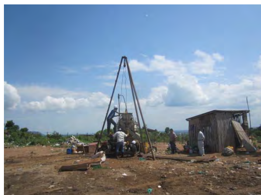
処分場ボーリング調査
