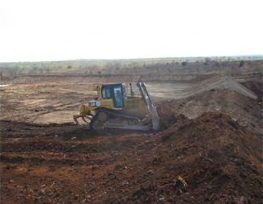
処分場の拡張工事
