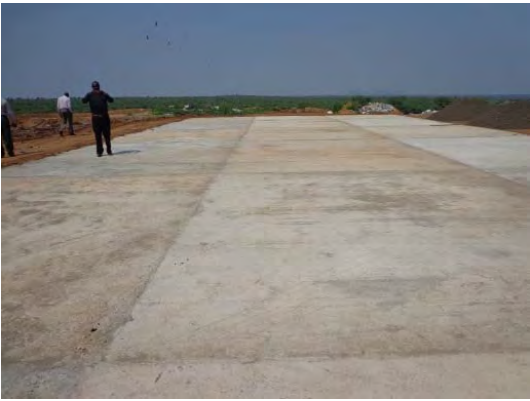
雨季用ダンピングプラットフォームの建設
