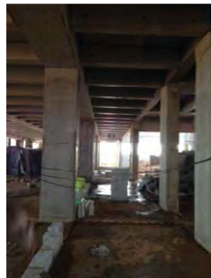
STRUCTURE : 良好な施工状況
