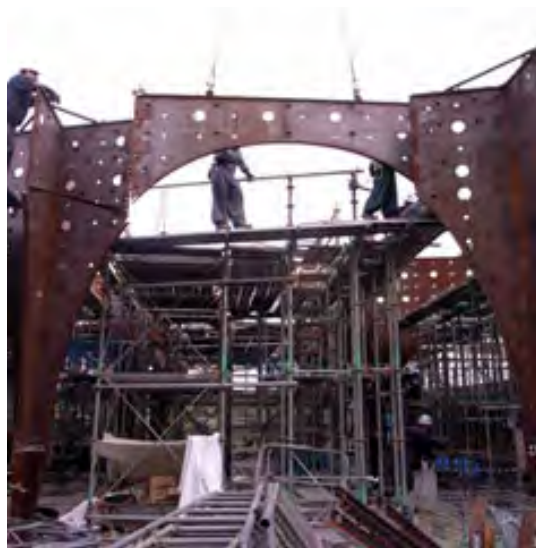
図 4. アーチの構造は、12mm の鋼板製
