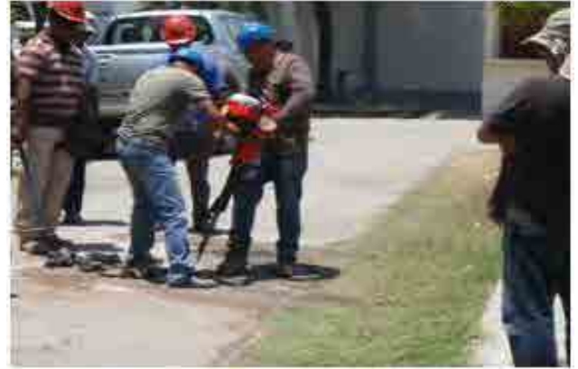
供与機材を使用してのポットホールの補修に関する実地訓練(2014年9月)
