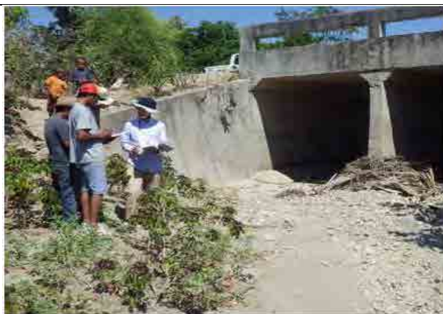
改良された橋梁DBのための現地調査の訓練(2014年9月)
