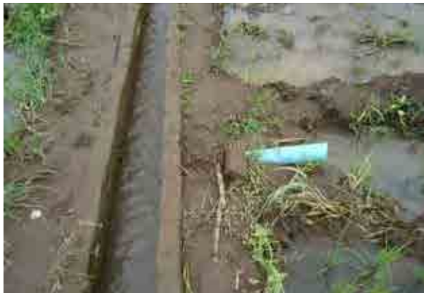
水路から圃場への取水施設 (パイプ) (Wenzide 地区)
