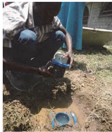
流量計分解掃除の実地訓練
