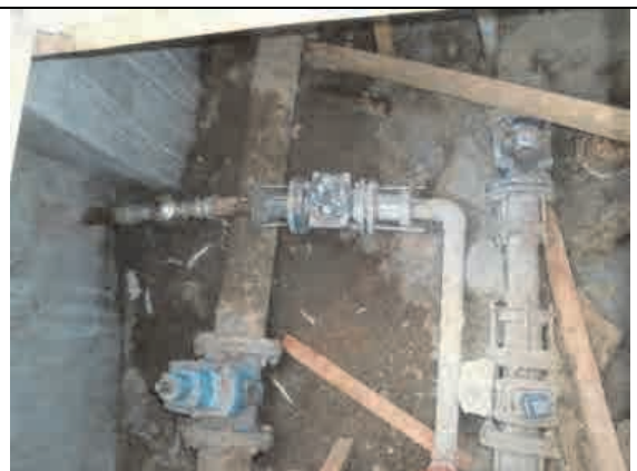
減圧弁の設置
