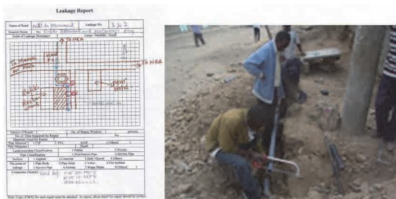
図 4-11 ナロックパイロットプロジェクトの施工の質の向上 (左：工事記録を残す、右：管理者が工事に立ち会い指導する)
