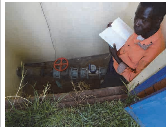
電磁流量計での流量計測
