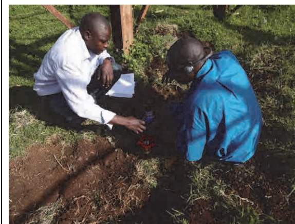
仕切弁の機能確認調査
