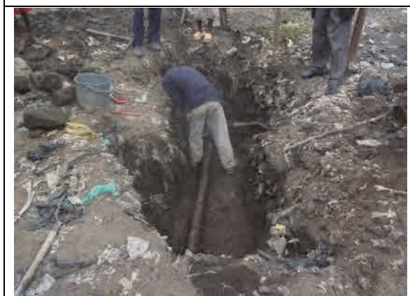
漏水箇所修理工事
