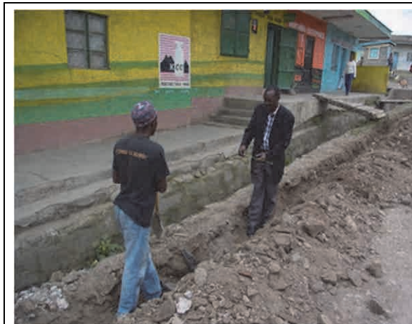
工事の施工監理改善（立会いを開始）
