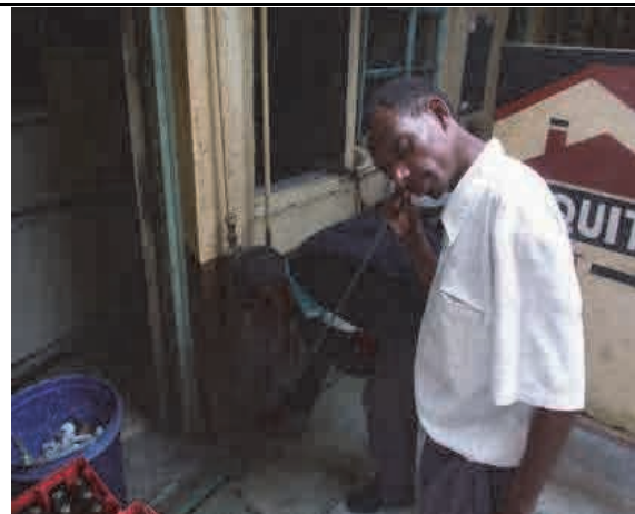
漏水探知の OJT
