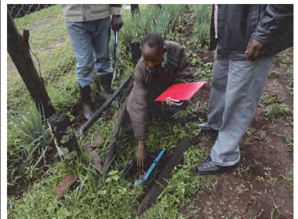
顧客メータの機能確認作業
