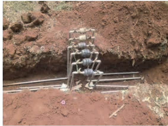
給水管敷設状況
