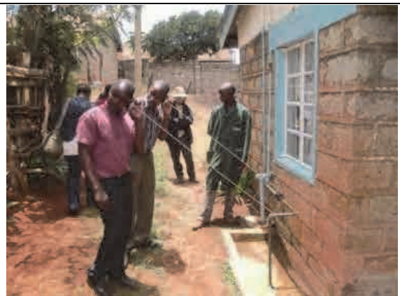
音聴棒による漏水探知の技術指導
