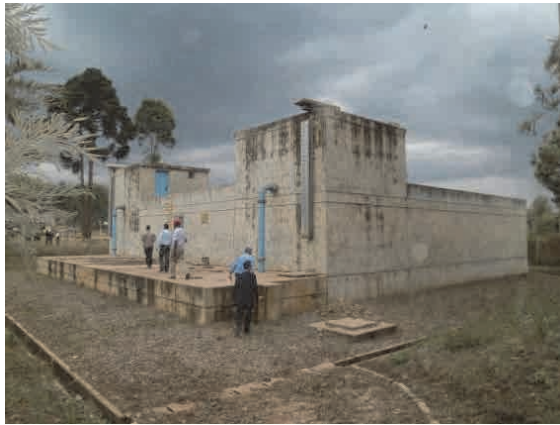
既存施設の確認 (写真は配水槽)
