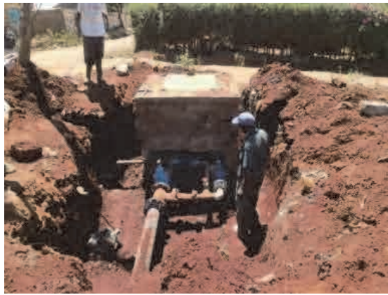
計量器室の築造
