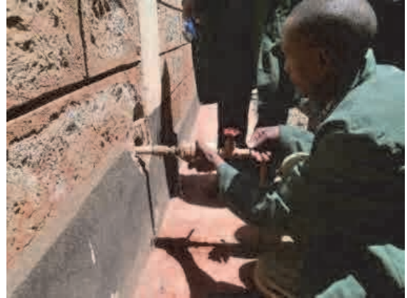
水道メータの交換作業
