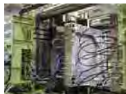
中継ブロックより配管
