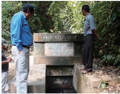
小規模灌漑局が施工した頭首工 (Blakin Lui 小規模灌漑事業) (Kolasib 県)
