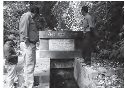
小規模灌漑局が施工した頭首工 (Blakin Lui 小規模灌漑事業) (Kolasib 県)
