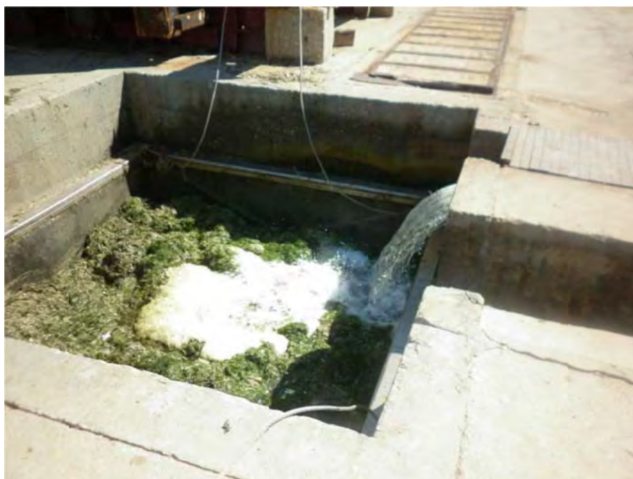
Figure 8.7-14 Sédiments, algues etc. retenus aux portes de la station de pompage
