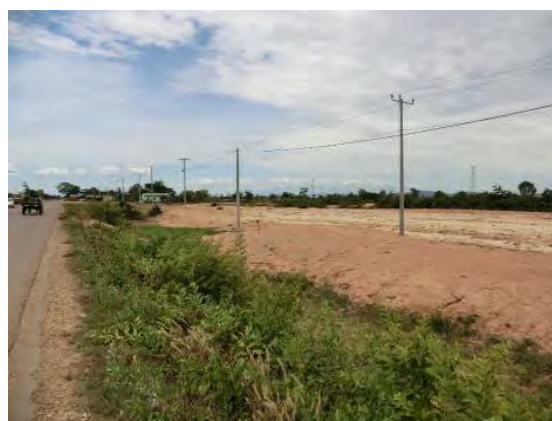
Land Fill for Factory (KP 193)
