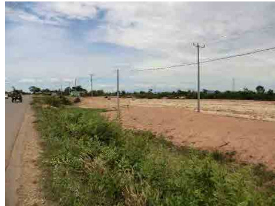
Land Fill for Factory (KP 193)
