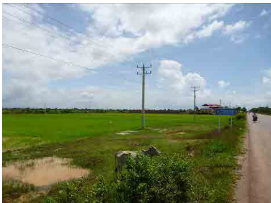
電柱 (KP 214 付近)
