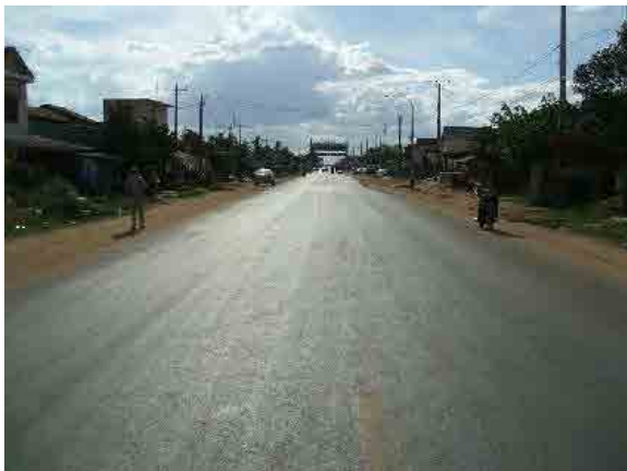
図 4-5 沿道の土地より路面の高さが低い区間
