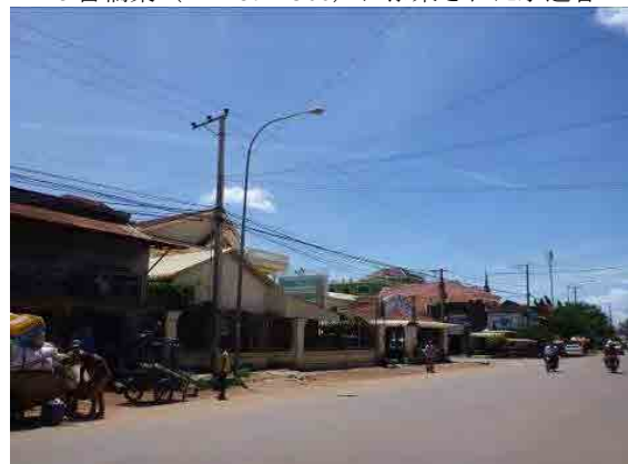
街路灯 (KP 186 付近)
