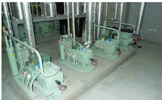
■既存半密閉型冷凍機 1台がオイル切れによる焼き付けを起し使用不能なため、更新のため入替する。
