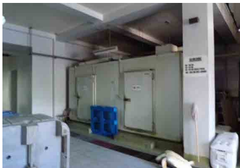
■-20℃冷凍庫+ -5℃冷蔵庫 冷媒 R22 使用。経年劣化が進んでいるため、 本プロジェクトで更新し、相手国の要望によ り冷媒をアンモニア化する予定
