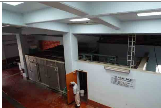
■-15℃冷凍庫と-5℃冷蔵庫 両方共 L4.8 x W25xH2.2m、冷媒 R22。経年劣化が進んでいるため本プロジェクトで更新し、相手国の要望により冷媒をアンモニア化する予定
