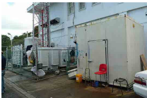
■新機械棟の設置予定地 手前の古い冷蔵庫は、使われておらず、相手 国により撤去される。
