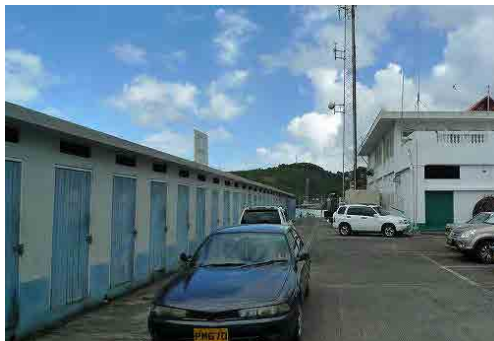
■既存漁具倉庫と市場管理棟 市場管理棟の背面はスタッフの駐車スペース であるが、新機械室の設置に伴い移動する。
