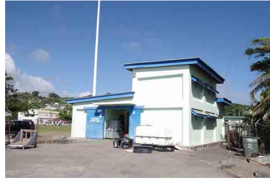
■冷蔵・冷凍棟入り口： 本プロジェクトで更新予定の冷却設備を内蔵
