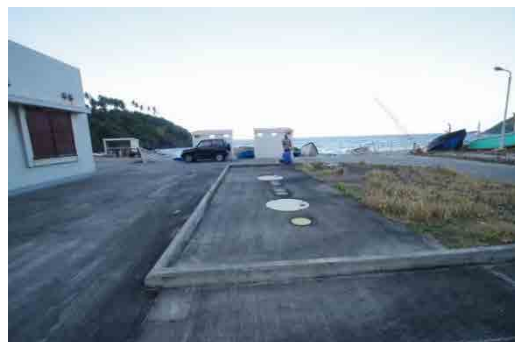
■地下ガソリンタンク：サイト奥部に位置する。棧橋に設置の給油機は錆による劣化で壊れたため、ここに給油機を転地・更新する
