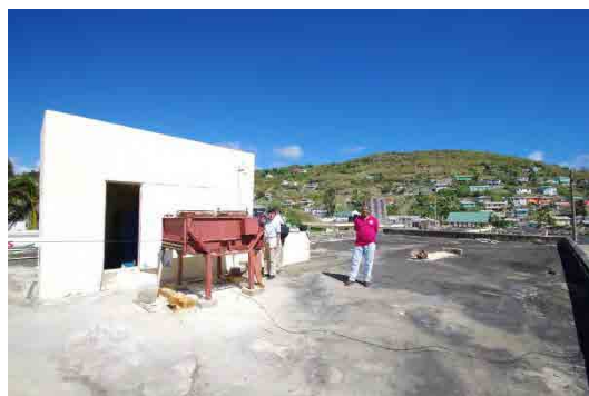
■ 本棟屋上 1 防水工事の後、太陽光パネルを設置する予定
