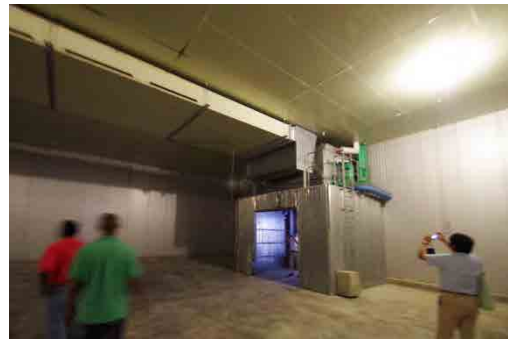
■冷蔵庫内観 入口上部の冷却ユニットを更新
