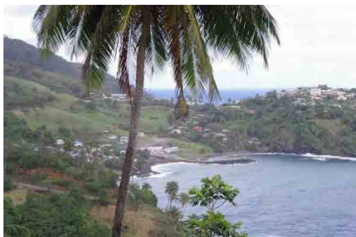
■オウイア水産センター遠景：大西洋に直面し、また湾奥に位置するので荒天時には海水飛沫がサイトに到達し、塩害が進んでいる
