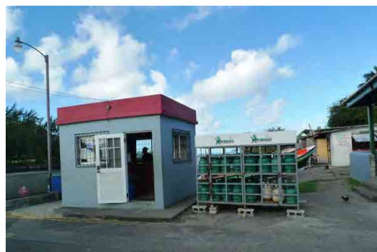
■ 製氷棟候補地 現在プロパンガスボンベが仮置きされている
