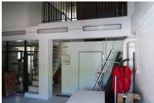
■ 貯水庫(上部に製氷機が設置されている) 製氷用冷凍機の故障で現在使われていない 左手に冷凍機が設置されている
