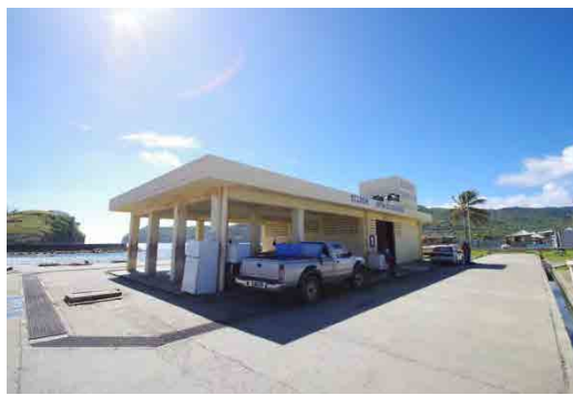
■ 漁業基地本棟外観(北から望む)
