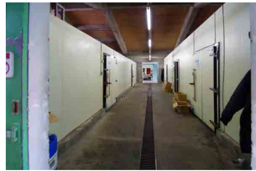
■ 冷蔵棟内観 右側は冷蔵庫、左側は急速凍結庫
