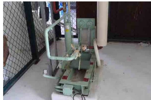
■ 故障のため取り外された冷凍機据付台(1基) 故障原因となった電子制御油面センサーを アナログ式センサーに転換し、事故再発を防止する
