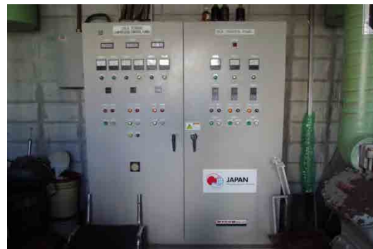
■ 急速凍結庫及び冷蔵庫用冷却設備用制御盤
