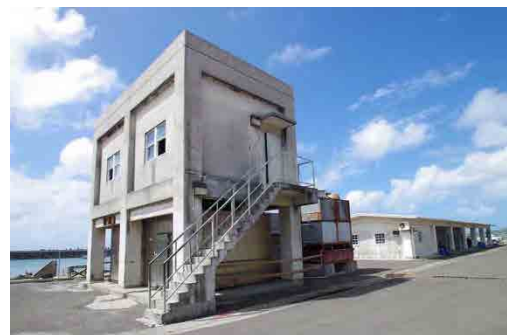
■製氷機棟 2 階部分の壁面を一部取り壊し、4 トン/日の製氷機を 2 基更新する。冷媒はアンモニア
