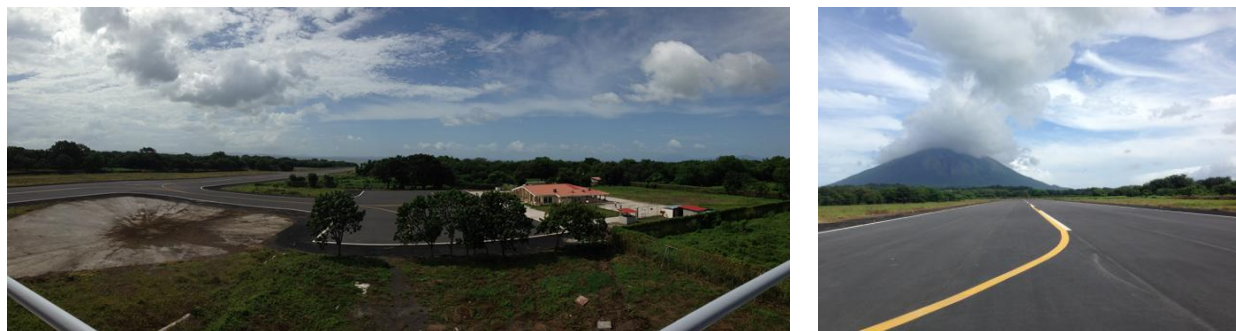
図 20.10.1 オメテペ空港の空港施設と滑走路
