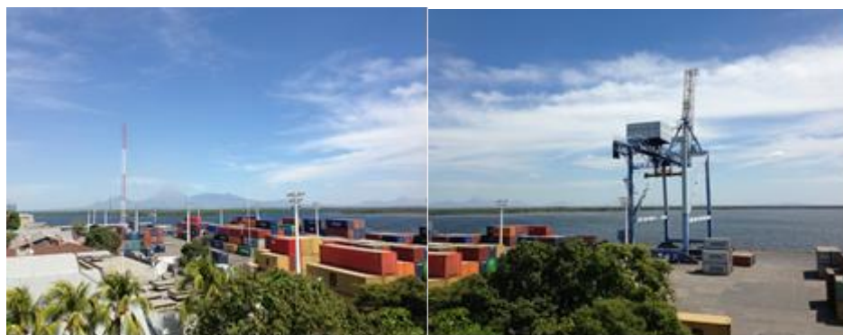
図 8.4.4 コリント港コンテナヤードおよびガントリークレーン
