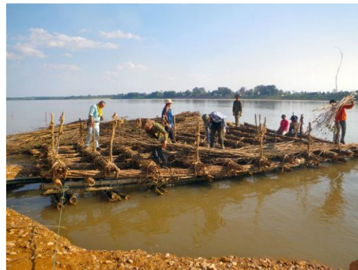
ຮູບພາບ 3.4-18 ການຕິດຕັ້ງ ກະຕ່າກ່າງໄມ້ປ້ອງກັນຕົ້ນຮາກຖານ ໃນໄລຍະການກໍ່ສ້າງ (ດ້ານຊ້າຍ: ໂຄງການກໍ່ສ້າງ ຂອງ IDI (2001); ດ້ານຂວາ: ສະໜາມກໍ່ສ້າງ ບ້ານປາກທວາຍ ແຂວງບໍລິຄຳໄຊ (2013))
