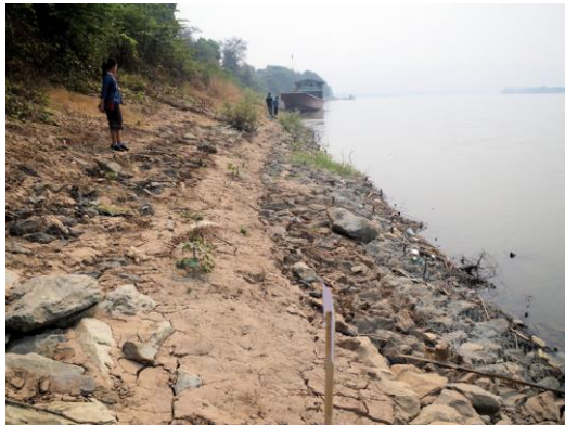
ຮູບພາບ 3.5-3 ຜົນການສ້ອມແປງຈຸດທີ່ມີການເປ່ເພ ບໍລິເວນໜ້າຕັດ 0+240m ທີ່ສະໜາມກໍ່ສ້າງ ບ້ານປ່າອ້ອຍ ໃນເດືອນມີນາ 2014
