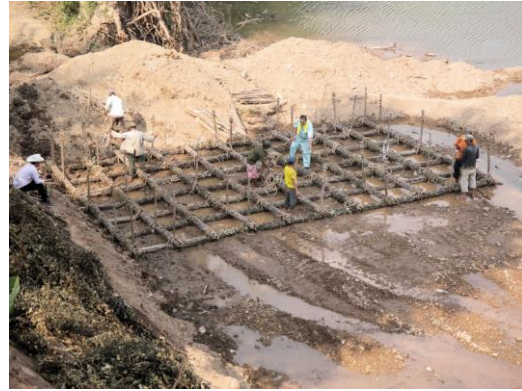
ຮູບພາບ 3.4-17 ການໃຫ້ຄໍາແນະນໍາຈາກ ຊ່ຽວຊານ ໄຈກາ ສໍາລັບວິທີການມັດທ່ອນກ່າງໄມ້ ໃຫ້ແກ່ ພະນັກງານວິຊາການໂຄງການ, ຜູ້ຮັບເໝົາ ແລະ ແຮງງານພາຍໃນທ້ອງຖິ່ນ.
