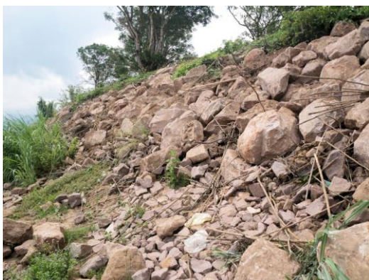
ຮູບພາບ 3.5-7 ຜົນການສ້ອມແປງຈຸດທີ່ມີການເປ່ເພ ທີ່ສະໜາມກໍ່ສ້າງບ້ານປາກທວຍ, ເດືອນພຶດສະພາ 2013
