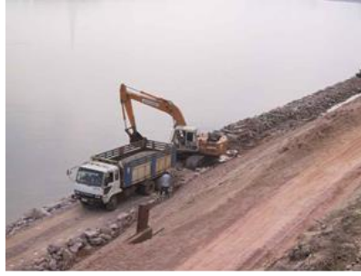
[ກາ ປ້ອງກັນ ຮາກຖາ ] ວ່າງຫີ ປ້ອງກັນ ຕີ ຮາກຖາ ຈໍາ ວ : 4,500 m 2 ຂະໜາດຫີ ໃຫ້ຍສຸດ: 450 mm
