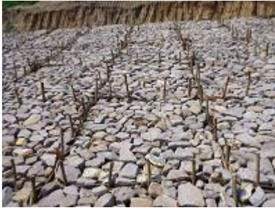
[ກາ ປ້ອງກັນ ຄວາມເີ້ ] ວ່າງຫີ ໃສ່ກະຕ່າກ່າງໄມ້ປ້ອງກັນ ຄວາມເີ້ ຫີ ປ້ອງກັນ ຄວາມເີ້ : 4,290 m 2 ຂະໜາດ: 150 – 250 mm
