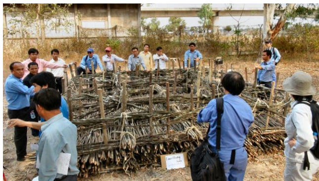
ຮູບພາບ 3.3-6 ການສໍາເລັດເຮັດປະກອບກະຕ່າກ່າງໄມ້ຂະໜາດ 4m x 4m (ຂະໜາດນ້ອຍທີ່ສຸດ)
