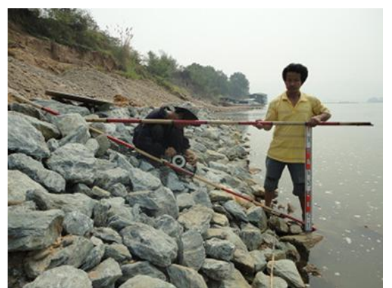
ພາຍຫລັງກໍ່ສ້າງສຳເລັດ ຜູ້ຮັບເໝົາການກໍ່ສ້າງກວດກາລະດັບ ທີ່ນລ່ອກຕີນໂຄງສ້າງ
