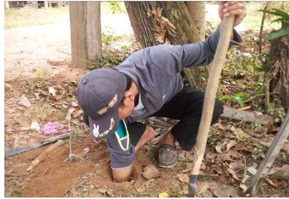
ການຝັງຈຸດຝາກ (Burying of Topo Point)
