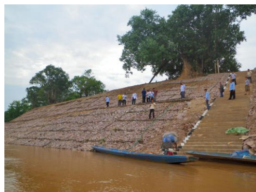
写真 3.4-14 (ポリカムサイ県パイロット工事)完成した河岸侵食対策工(2013 年 6 月)
