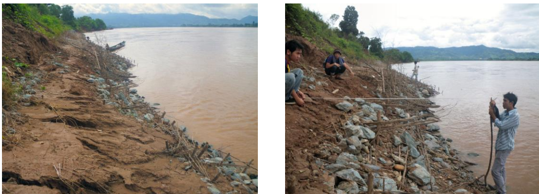
写真 3.5-2 法覆工の変形と C/P 職員によるモニタリング状況(2012 年 8 月)
