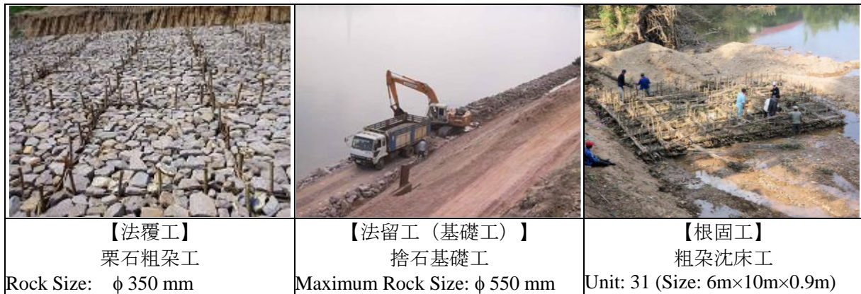
図 3.4-12 ルアンパバン県パイロット工事で実施される主な工種
