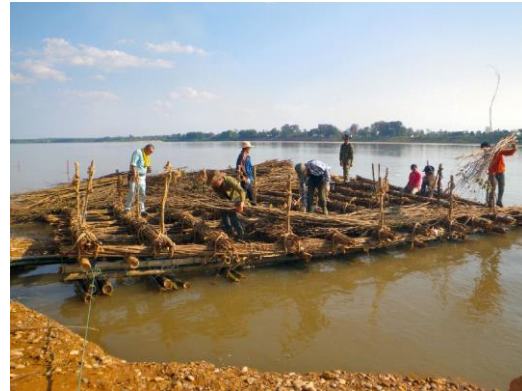
写真 3.4-18 過去のパイロット工事における粗朶沈床の設置状況
