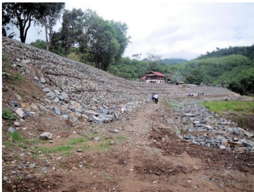
写真 3.4-24 (ルアンパバン県パイロット工事)完成した河岸侵食対策工(2014年6月)
