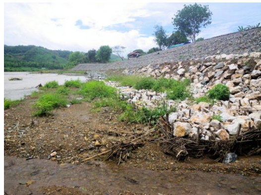
写真 3.4-24 (ルアンパバン県パイロット工事)完成した河岸侵食対策工(2014年6月)
