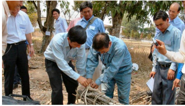
写真 3.3-4 JICA 専門家の実地指導の下 C/P 職員が行った連柴結束の様子
