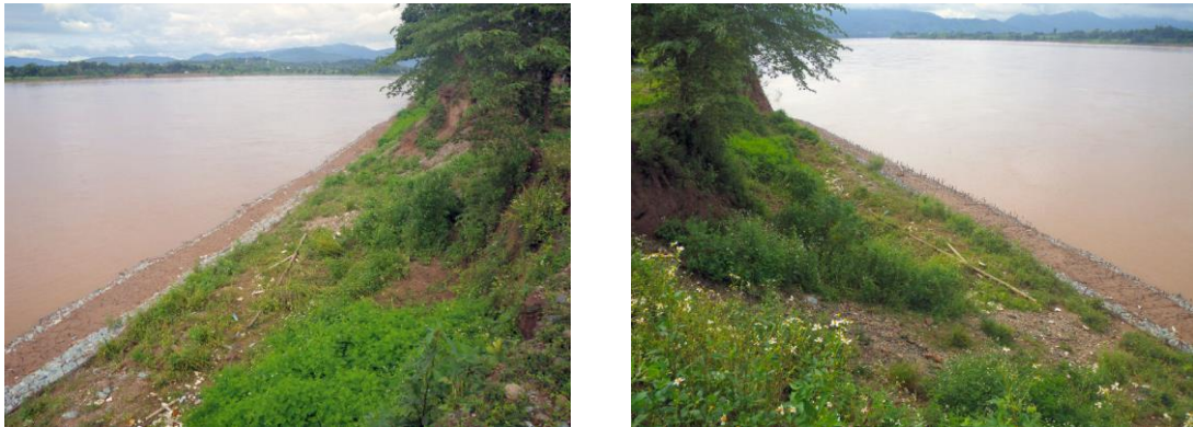
写真 3.5-1 パオイ地点パイロット工事サイトの状況(2012 年 8 月)
