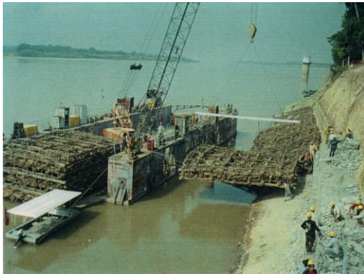
写真 3.4-18 過去のパイロット工事における粗朶沈床の設置状況
