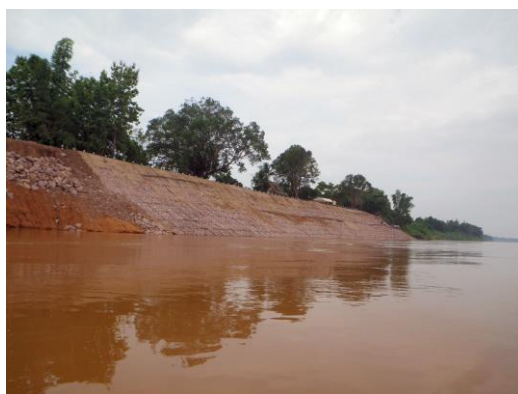
写真 3.4-14 (ポリカムサイ県パイロット工事)完成した河岸侵食対策工(2013 年 6 月)
