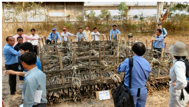
写真 3.3-6 完成した粗朶沈床(一辺は 4 メートル)
