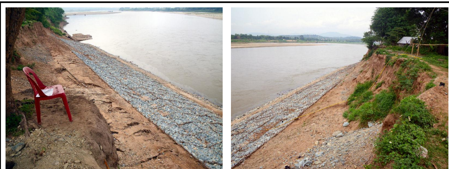
竣工時の状況（2012年5月）
