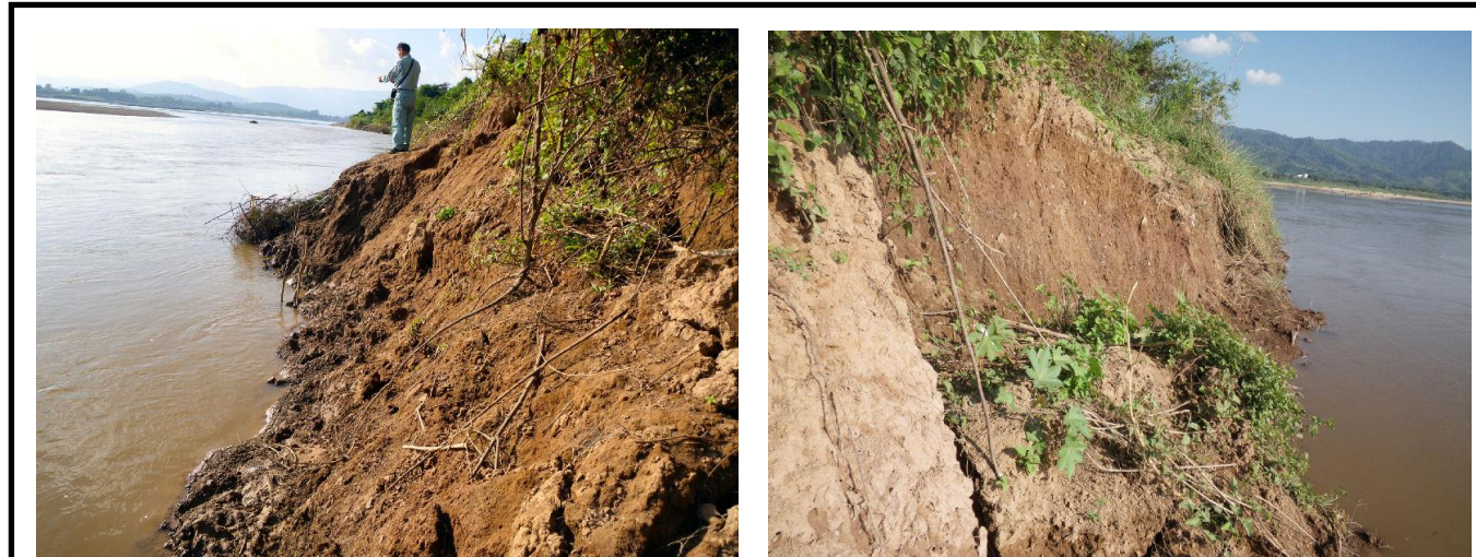
試験施工前の河岸状況（2010年12月）
