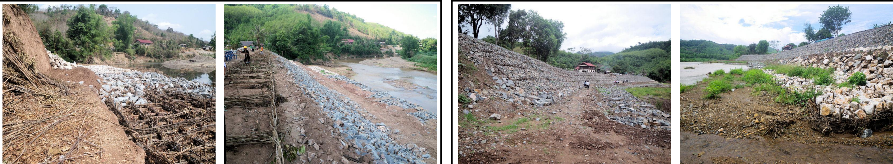
試験施工の状況（2014年3月～2014年5月）
