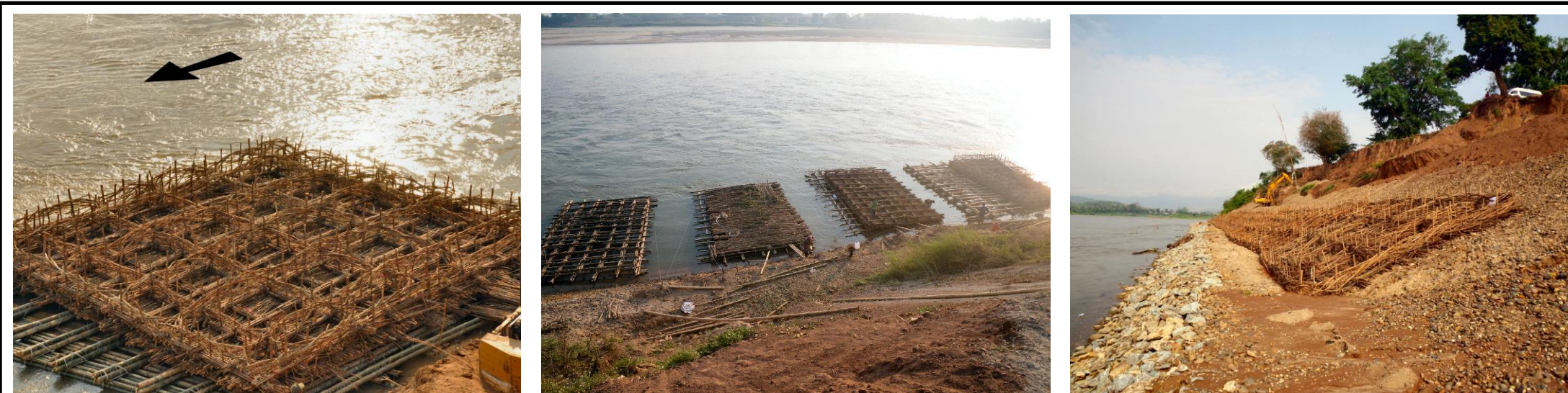
試験施工の状況（2012年1月～2012年5月）
