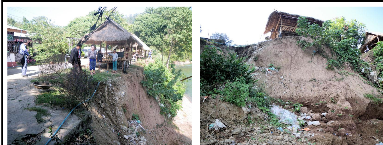
試験施工前の河岸状況（2010年12月）
