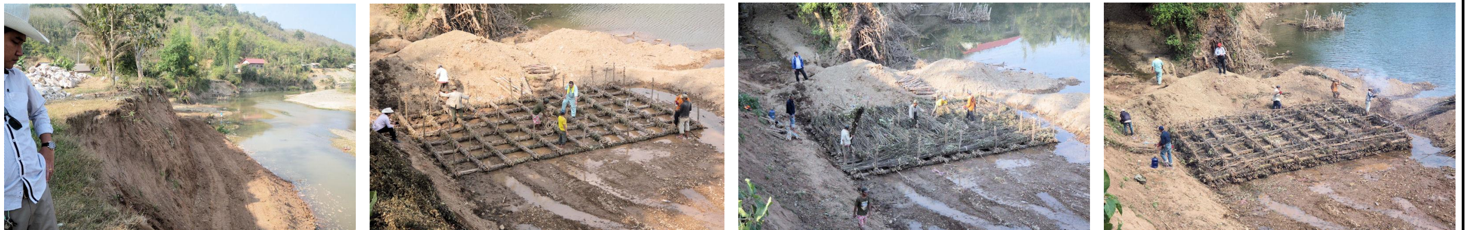
試験施工の状況（2014年2月）
