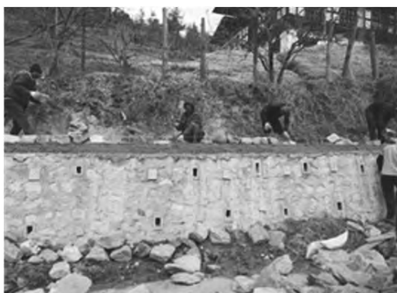
石積み擁壁工（施工中） 国道1号線
