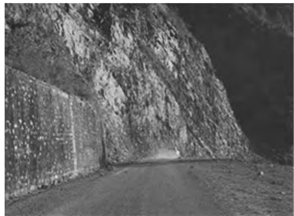
石積み擁壁工 国道4号線 (Zhemgang-Gelephu)
