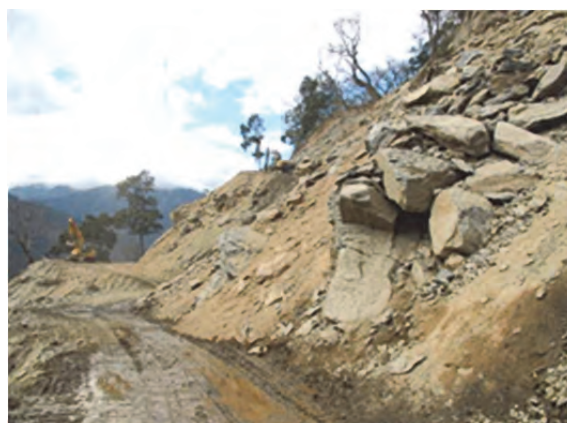
岩塊を含む崩積土
