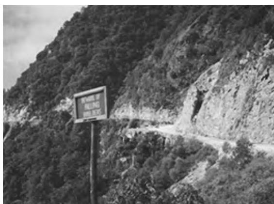
国道5号線 (Gelephu-Damphu) 落石と岩盤崩壊の危険がある。 手前は落石注意の看板。
