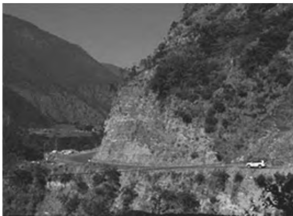
Sarpang -Wangdi Phodrang : 切土遠景
