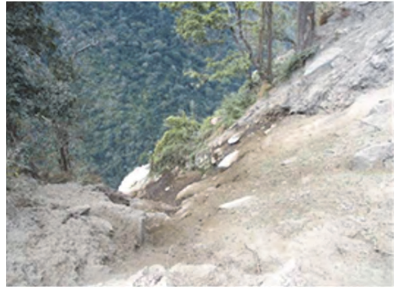
谷側斜面、非常に急である。
