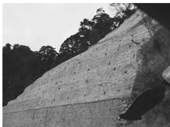
石積み擁壁工 国道1号線（ドチュ・ラ峠付近）
