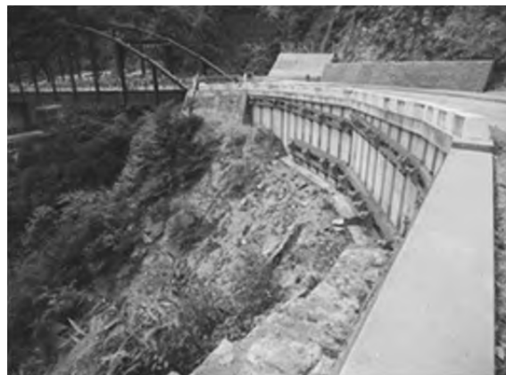
アンカー工+コンクリート矢板工 国道5号線（Sarpang-Damphu）
