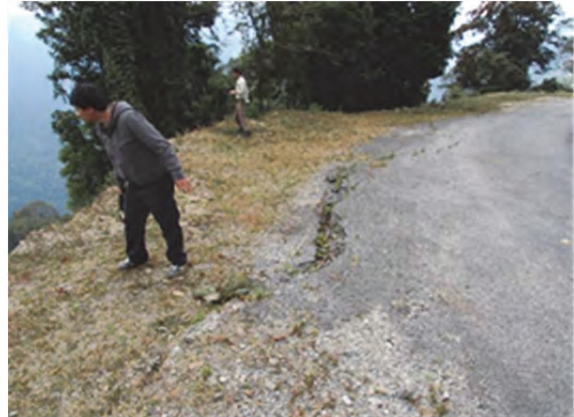
現在の滑落崖(左)と滑落崖の後退を示唆する開口亀裂
