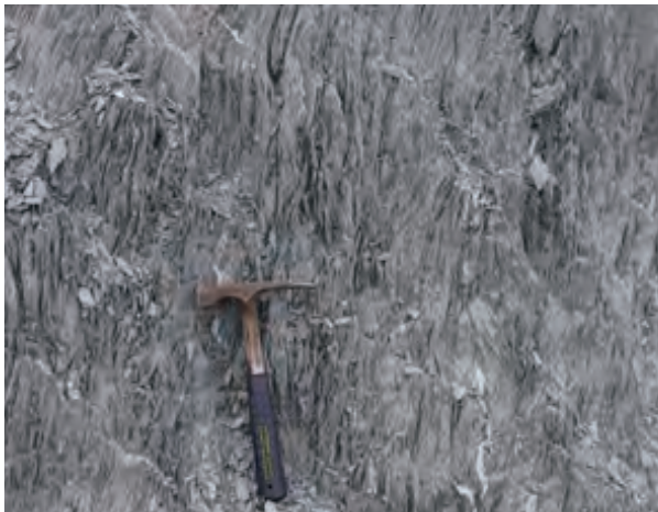
国道 4 号線 (Zhemgang-Gelephu) Box Cutting 崩壊現場
