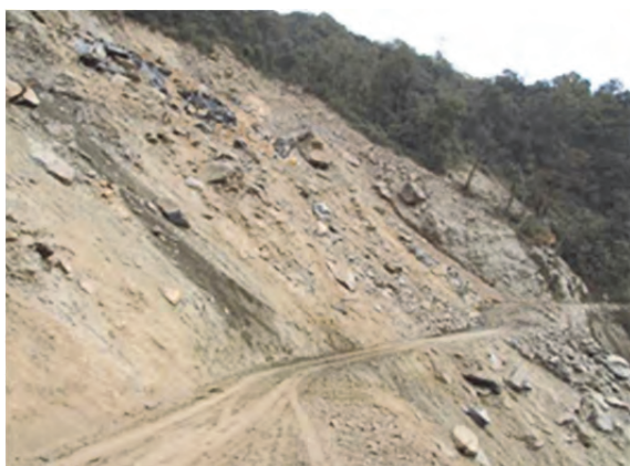
山側斜面、崩積土の状況
