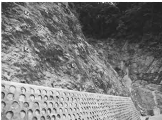
コンクリート吹付+ロックボルト工 国道5号線（Sarpang-Damphu）
