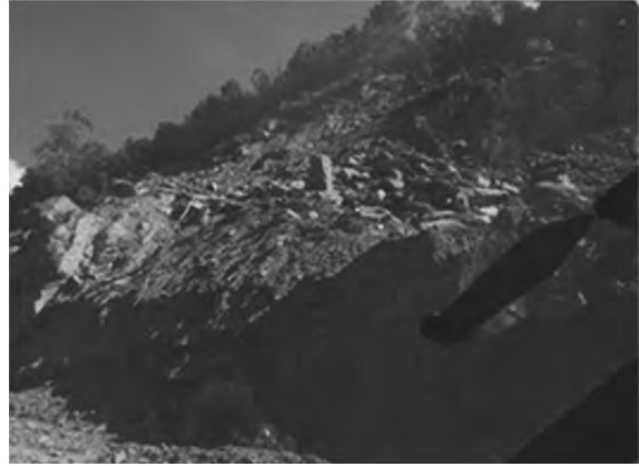
Lobeysa-ペレ・ラ：流れ盤斜面の崩壊
