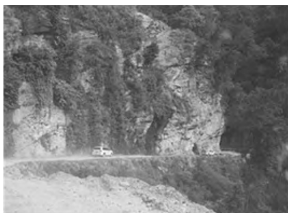
Trongsa-Zhemgang : 岩盤斜面
