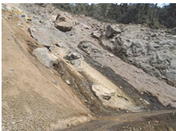
終点側湧水状況
