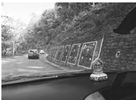
石積み擁壁工 国道1号線（ドチュ・ラ峠-Lobeysa）
