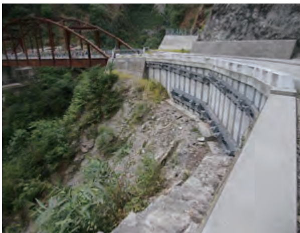
国道 5 号線 (Sarpang-Damphu) Loring 橋取付道路 (第 3 次橋梁架け替え計画)
