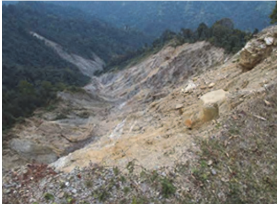
急傾斜を呈する谷側斜面
