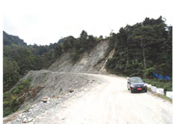
遠景、山が低いいため切り込むことが可能だが、高圧電線鉄塔に影響する可能性がある。
