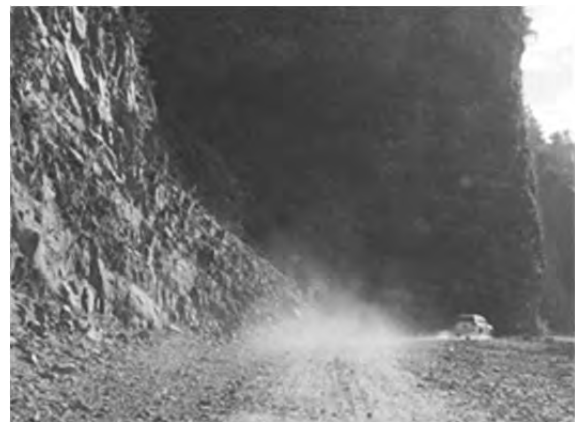
Zhemgang-Gelephu : 岩盤斜面
