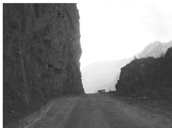
Trongsa-Zhemgang : 岩盤斜面
