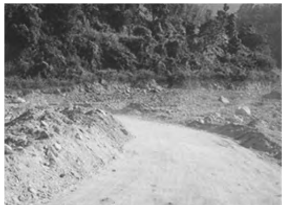
Gelephu-Sarpang : 堆積域の仮設道路状況
