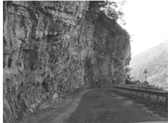
Zhemgang-Gelephu : 岩盤斜面
