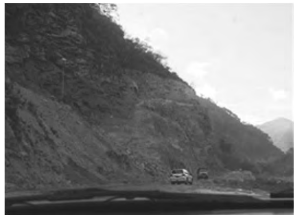
Sarpang -Wangdi Phodrang : ダム工事現場の状況
