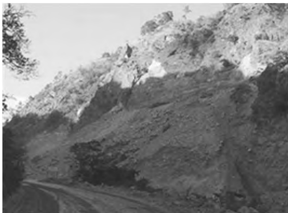
Sarpang -Wangdi Phodrang : ダム工事現場の状況
