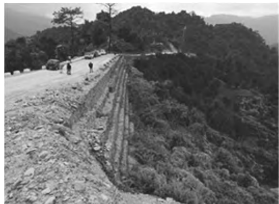
ガビオン擁壁工 国道4号線 (Zhemgang-Gelephu)
