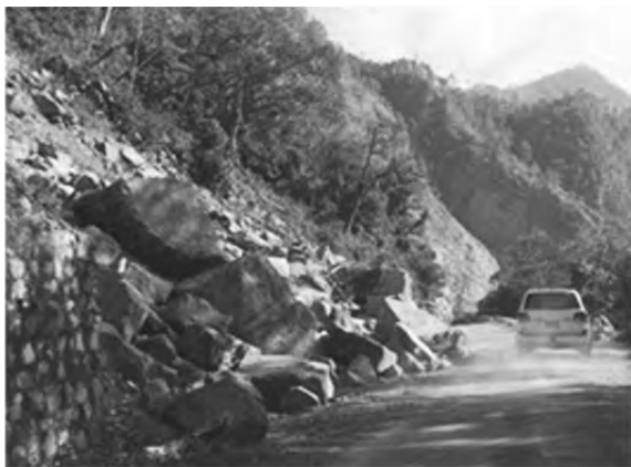
Zhemgang-Gelephu : 斜面崩壊
