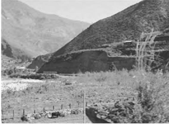
切土斜面遠景、裾の一部に擁壁
