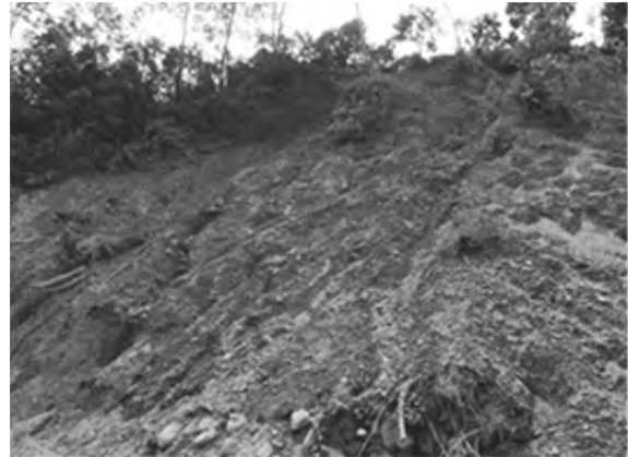
Zhemgang-Gelephu : 左写真の山側斜面 浸食が著しく、更なる崩壊が予想できる。
