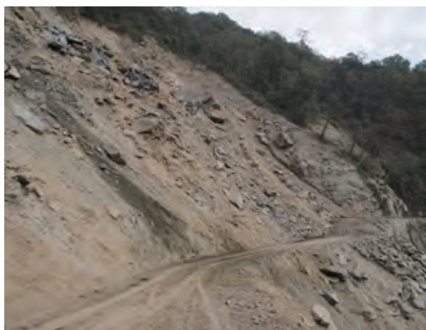
国道 4 号線 (Trongsa-Zhemgang) Reotala 崩壊現場
