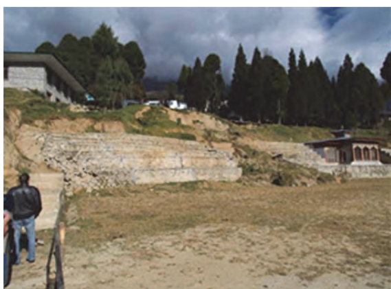
上方斜面、学校敷地での地すべり
