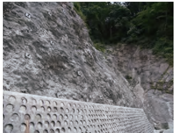
国道 5 号線 (Sarpang-Damphu) Loring 橋取付道路 (第 3 次橋梁架け替え計画)
