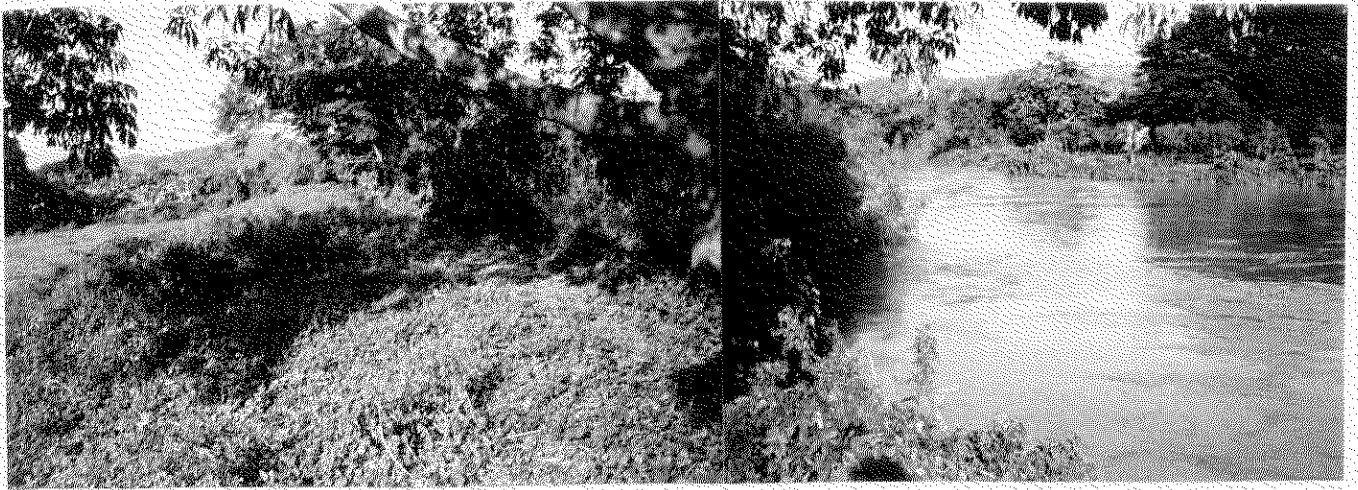
ウスルタン地区補強堤防（1993年補強工事、堤防幅3m、堤防高2m）
