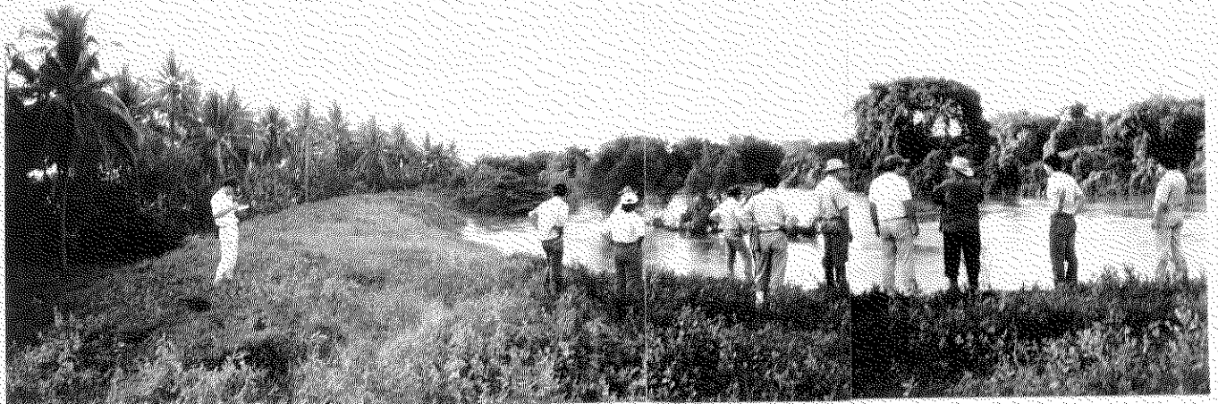
ウスルタン地区破堤後築造された堤防 （堤防幅＝6～7m、堤防高＝4m、湾曲部石積護岸施工あり）
