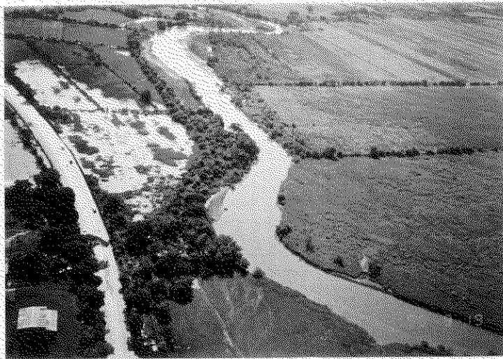
下流の流下能力不足地点の浸水状況
