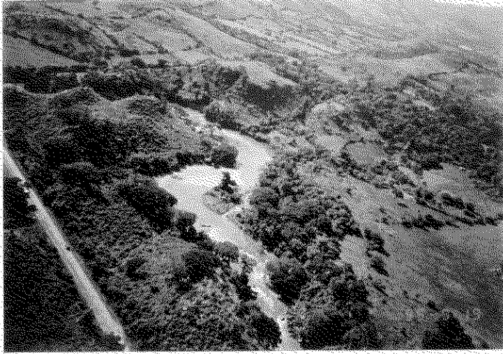
オロメガ湖下流において流下能力を 固定していると思われる地点
