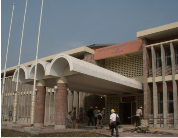
キンシャサ中級保健人材養成校 (IEMK) 建設現場 (1)
