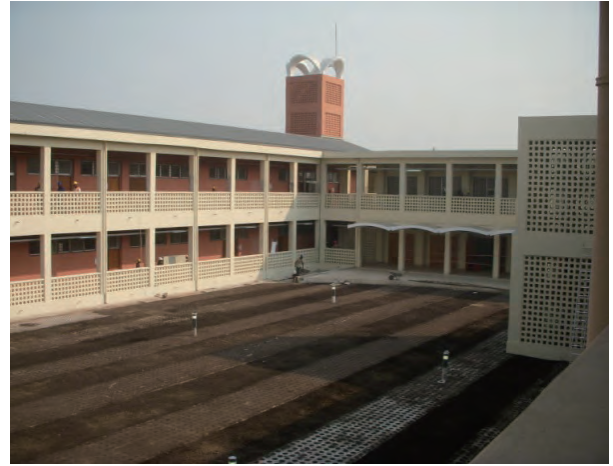
IEMK 建設現場 (2)
