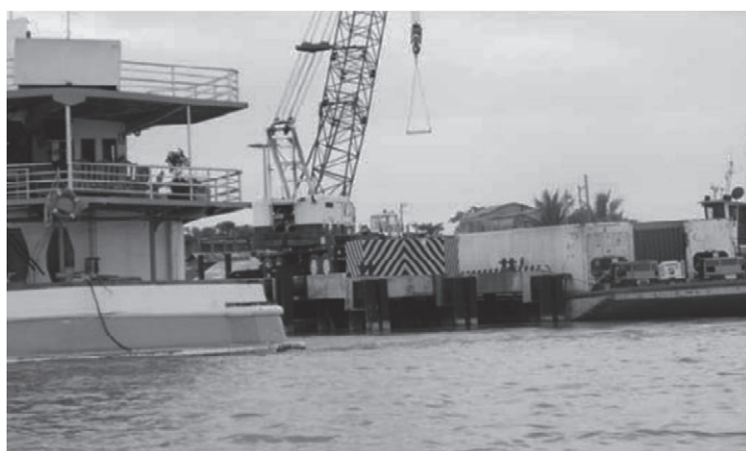
Fig. III. 3.2.23 Estado de manipulación de madera
