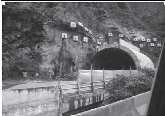
Obras de ejecución del túnel
