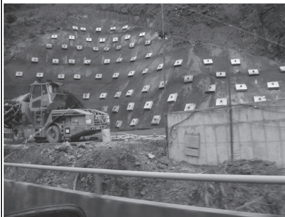
Obras del túnel de tránsito de dos manos.
